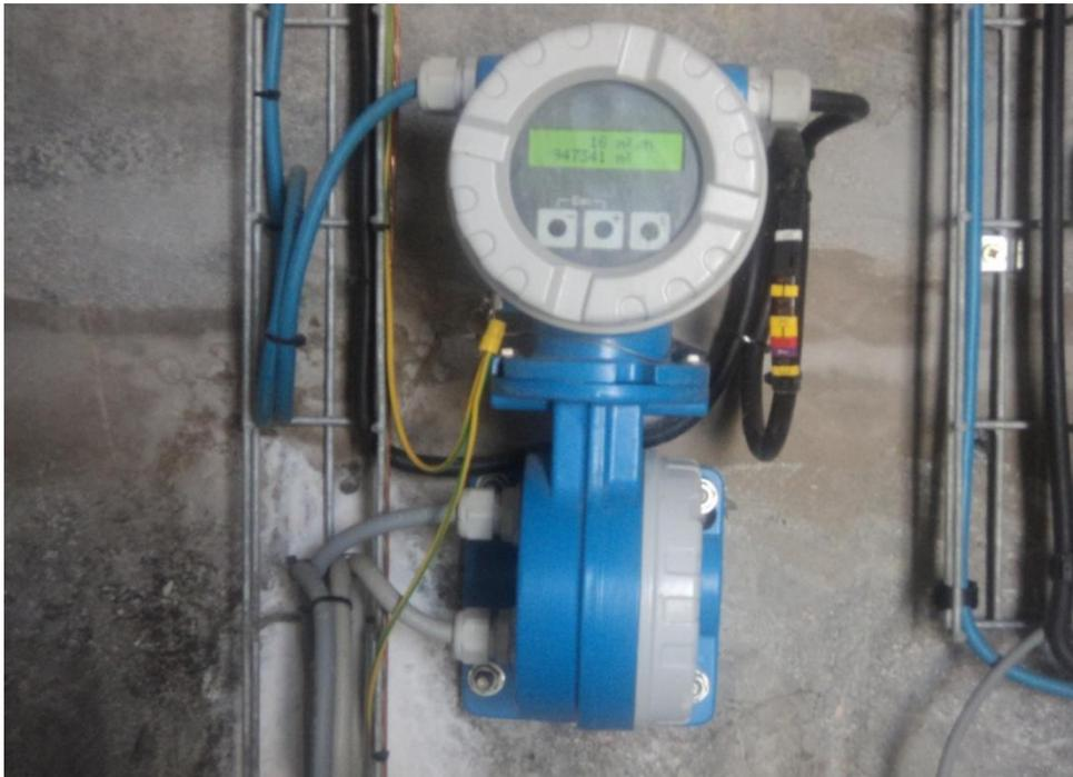
**Figure II.3:** Débitmètre électromagnétique
