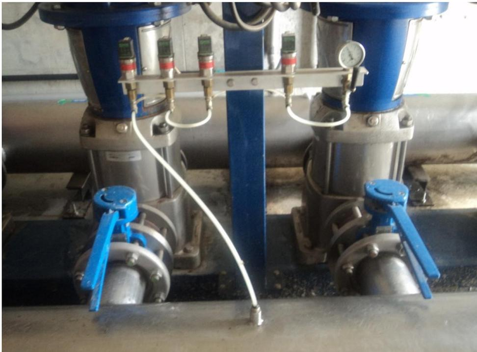
**Figure II.2 :** Capteur de pression
