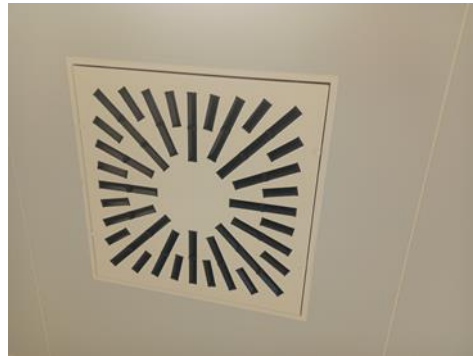
Figure IV.8 : représentation d'un diffuseur a jet hélicoïde
