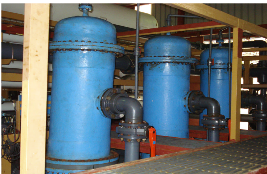
Figure II.5 : Illustration d'unité de filtres d'affinage (microfiltres)
