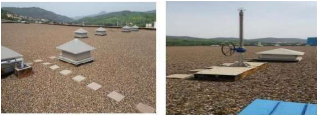
Figure 10: Points d'injection du chlore au niveau de réservoir.
