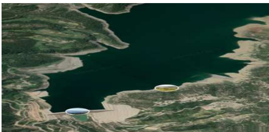
Figure 01: Image satellitaire du barrage Koudiat Acerdoune prise par Google Earth 2022.
