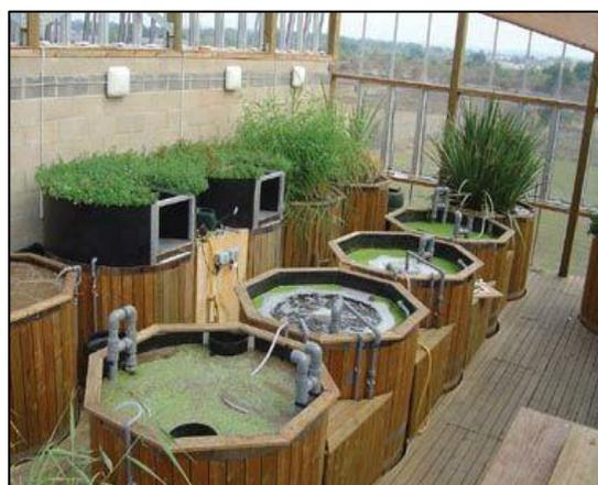
L'eau de pluie et les eaux recyclées assurent le cinquième de la consommation du village. L'eau de pluie est stockée dans des réservoirs situés dans les fondations du bâtiment. Une partie des eaux usées est traitée sur place par une « living machine ». Cette machine vivante se compose de sept bassins, reliés entre eux, où microbes et plantes travaillent à épurer l'eau souillée.
