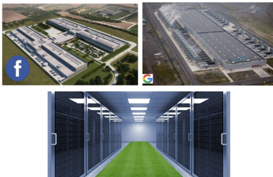
FIGURE 2.4 – Exemple de deux data center, un de Facebook et l'autre de Google
