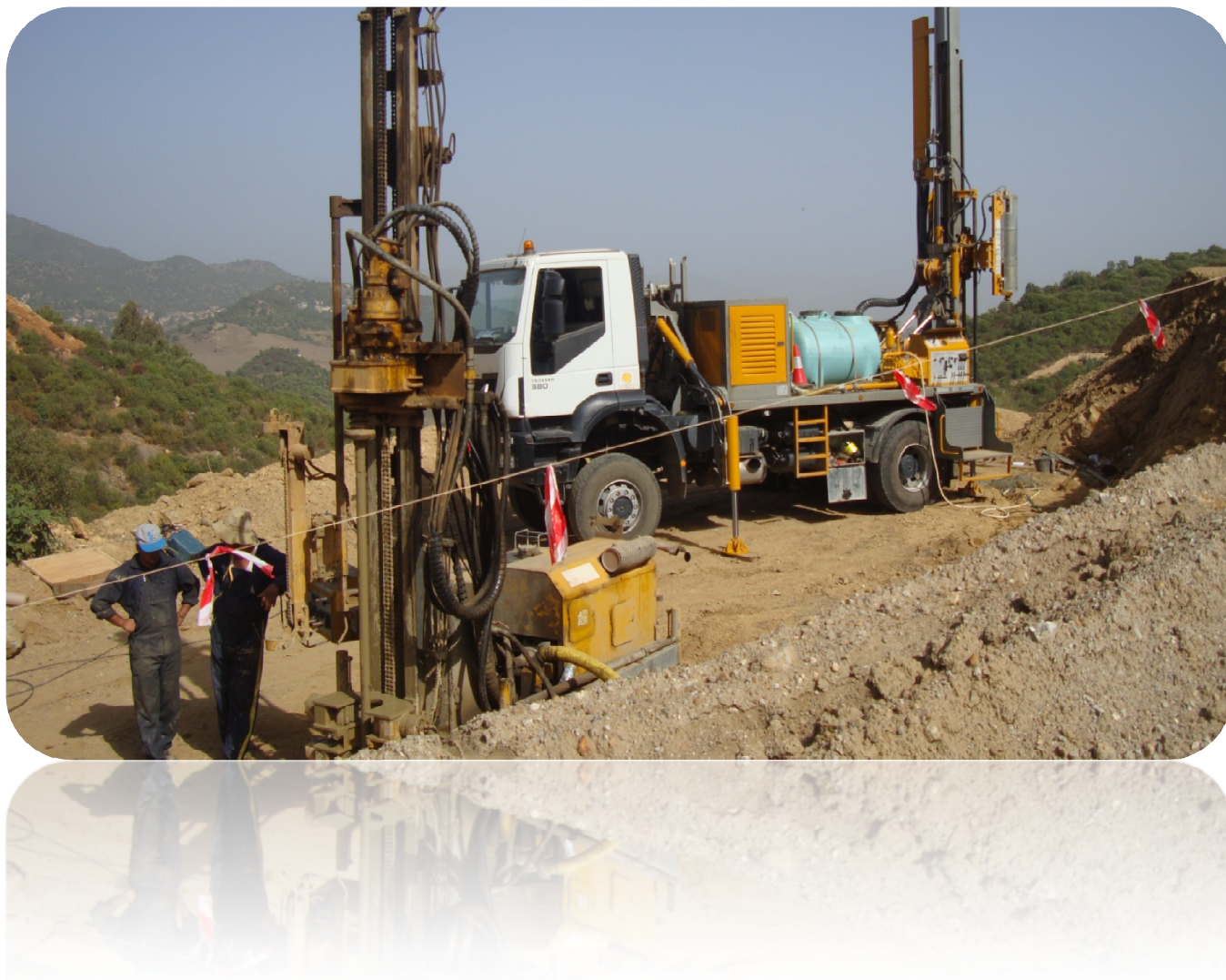
Annexe 05: Une sondeuse d'un carottier à prise d'échantillons sur le PK 15+550m.
