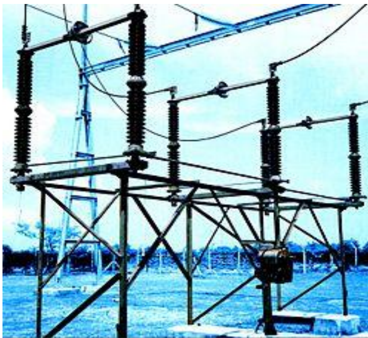
Figure III.5 Sectionneur moyenne tension
