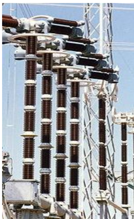
Figure III.6 : Disjoncteur à air comprimé
