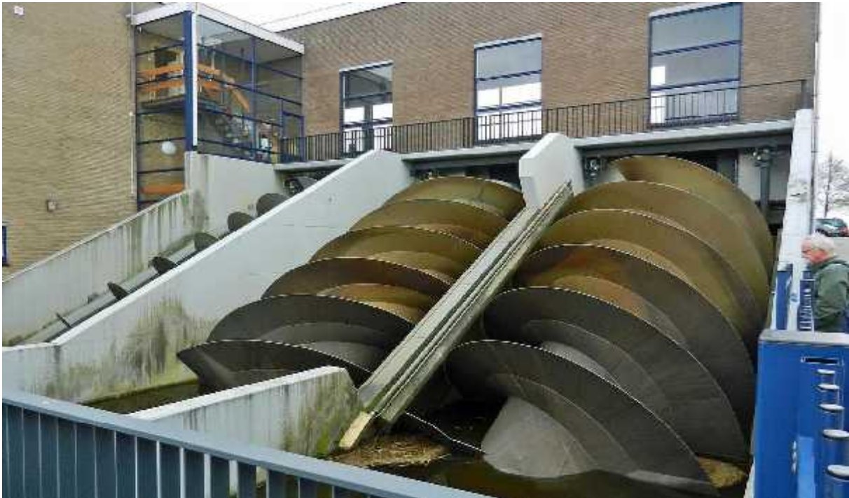
Figure I.9 Machine élévatoires simple à vis d'Archimède. [9]
