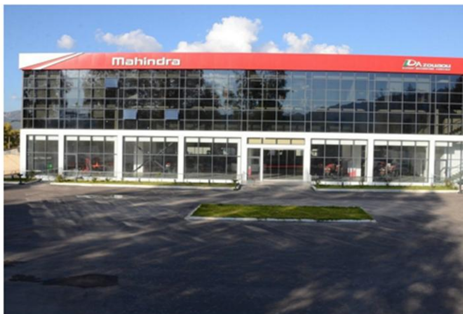
Figure I.1 Siège de l'Entreprise
