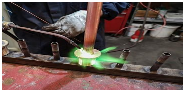
Figure II.48 : Soudage autogène
