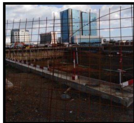
Figure 40 : vue sur le chantier. Source : auteurs.
