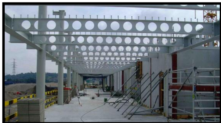
Figure 59 : poutre alvéolaire. Source : www.constructalia.arcelormittal.com .
