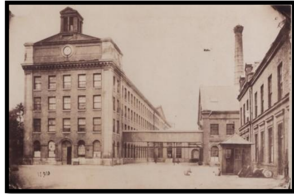
Figure 36: Vue sur l'ancienne usine de Cotton. Source : www.seine-innopolis.com .
