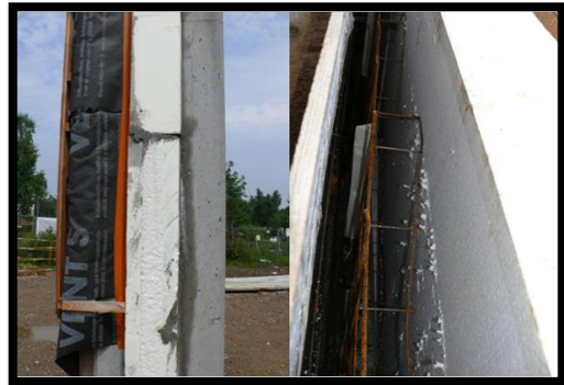
Figure 52 : vue sur le mur.
