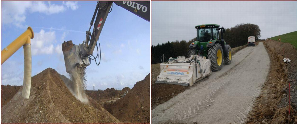
Figure II.5 : malaxage de sol avec le ciment et mise en œuvre de sol ciment
