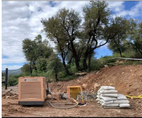
Figure 52 : La pompe a boue et la bentonite (original)
