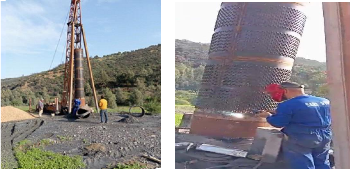
Figure 41: La mise en place de tubage
