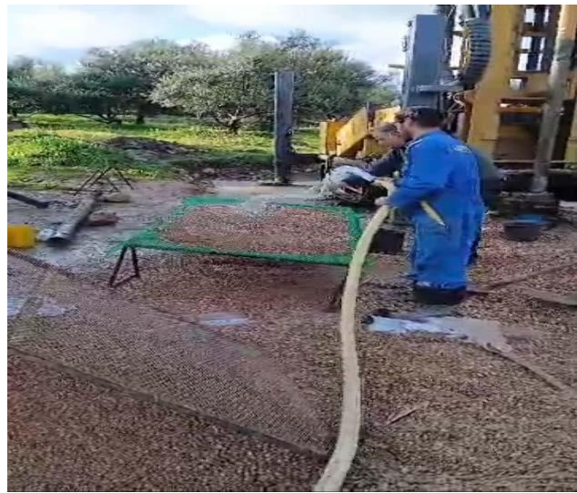
Figure 55 : La mise en place de massif filtrant (original)
