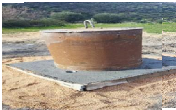
Figure 43 : L'aménagement de la tête de forage
