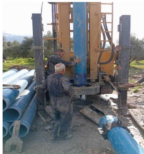
Figure 54 : La mise en place de tubage (original)
