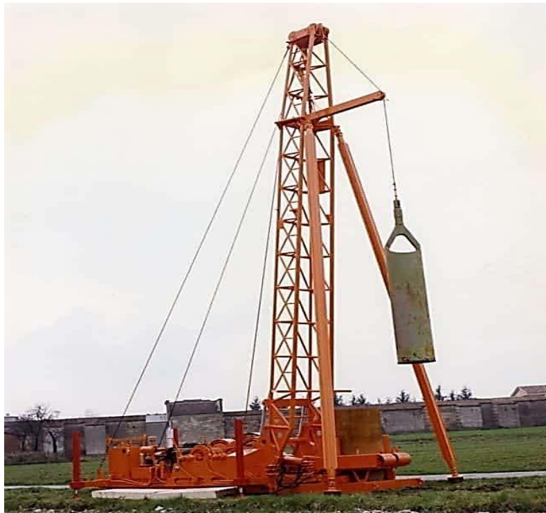
Figure 6 : Forage par battage.
