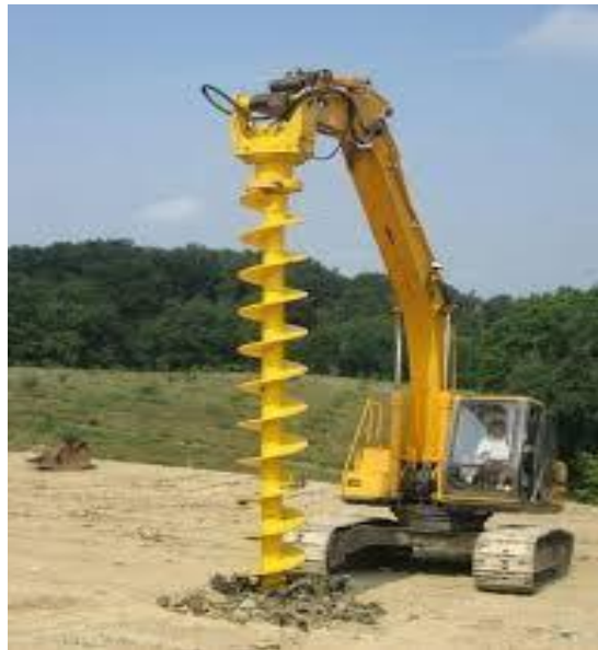
Figure 10 : forage par tarière
