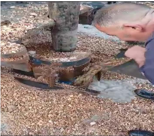
Figure 55 : La mise en place de massif filtrant (original)
