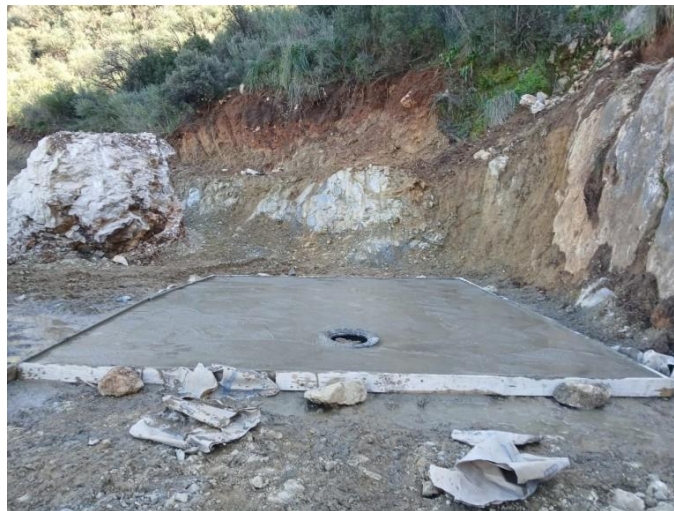
Figure 33 : La plateforme de forage (original)
