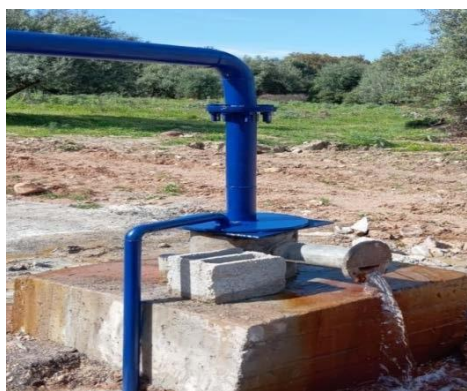
Figure 59 : L’aménagement du forage
