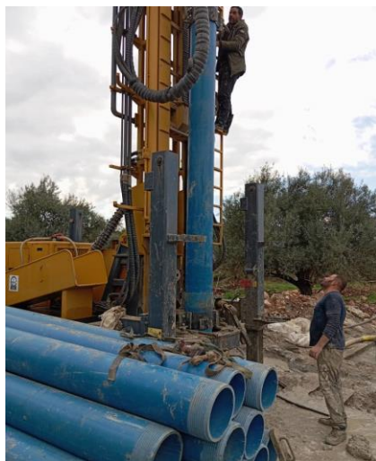
Figure 54 : La mise en place de tubage (original)
