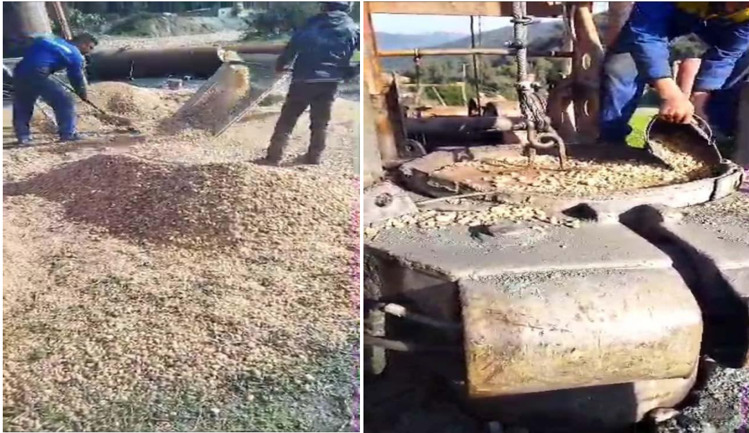
Figure 42 : La mise en place de massif filtrant
