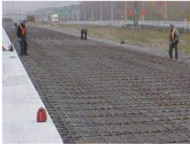
FIGURE IV.8 – Chaussée en béton armé.
