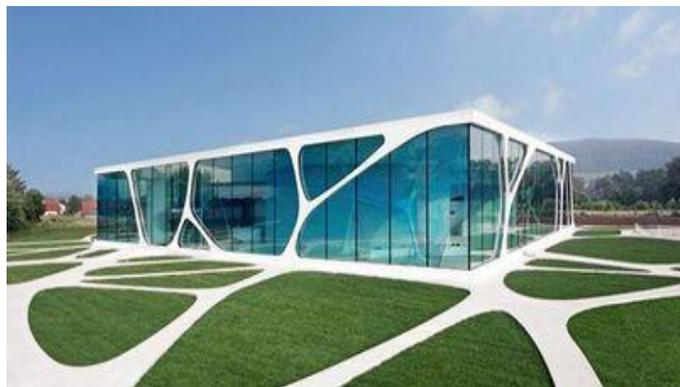
Figure 158: Exemple de façade traitée avec du corian
