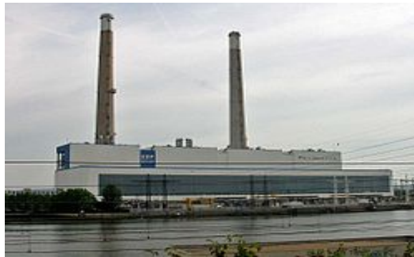
Fig. II.2 : Centrale thermique a flamme
