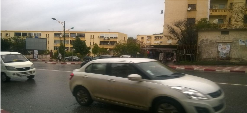
Fig : vue sur d'ensemble sur les bâtiments 5 juillet avant l'intervention.
