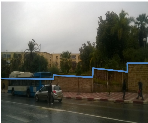
Fig 45 : hôtel belloua inaccessible au public
