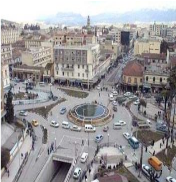
fig : Vue sur le carrefour avant l'intervention
