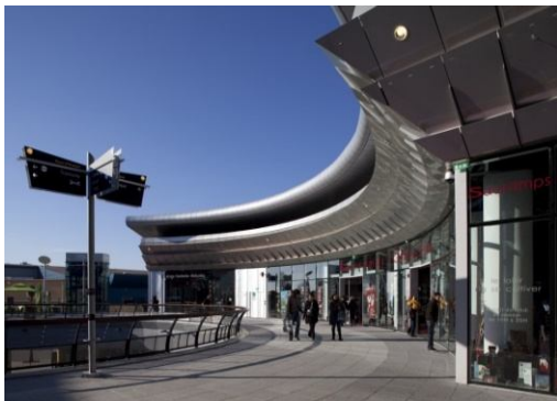
Fig 04 : Une cour centrale à ciel ouvert
