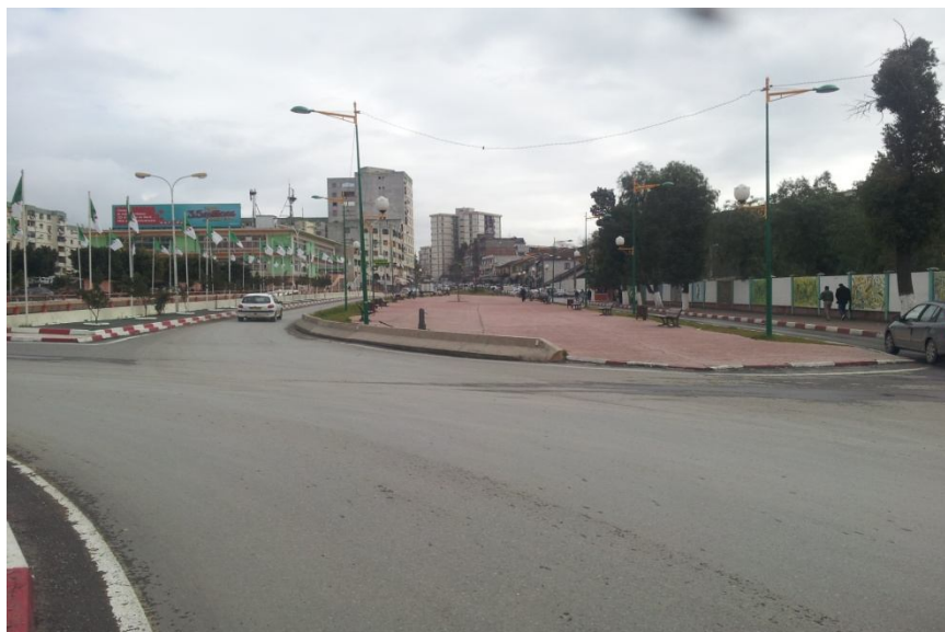
Fig 03 : vue sur la placette de l'ancienne gare avant l'intervention
