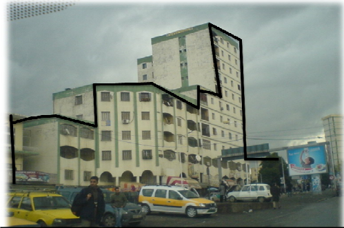
Fig52 : LEPLF un gabarit dégradé
