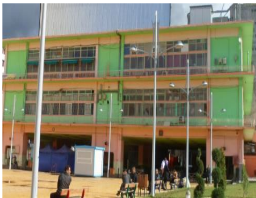
Fig51 : l'ex gare- routière en état dégradé.
