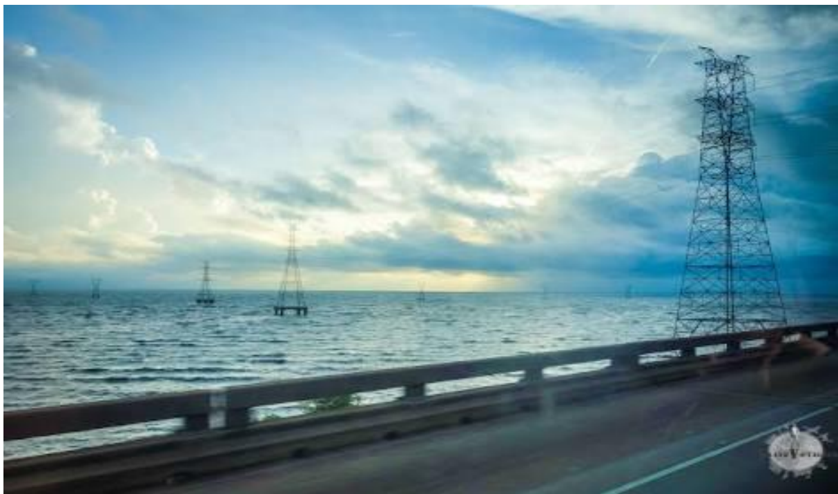
Figure II.2 : La ligne haute tension sous pollution marine
