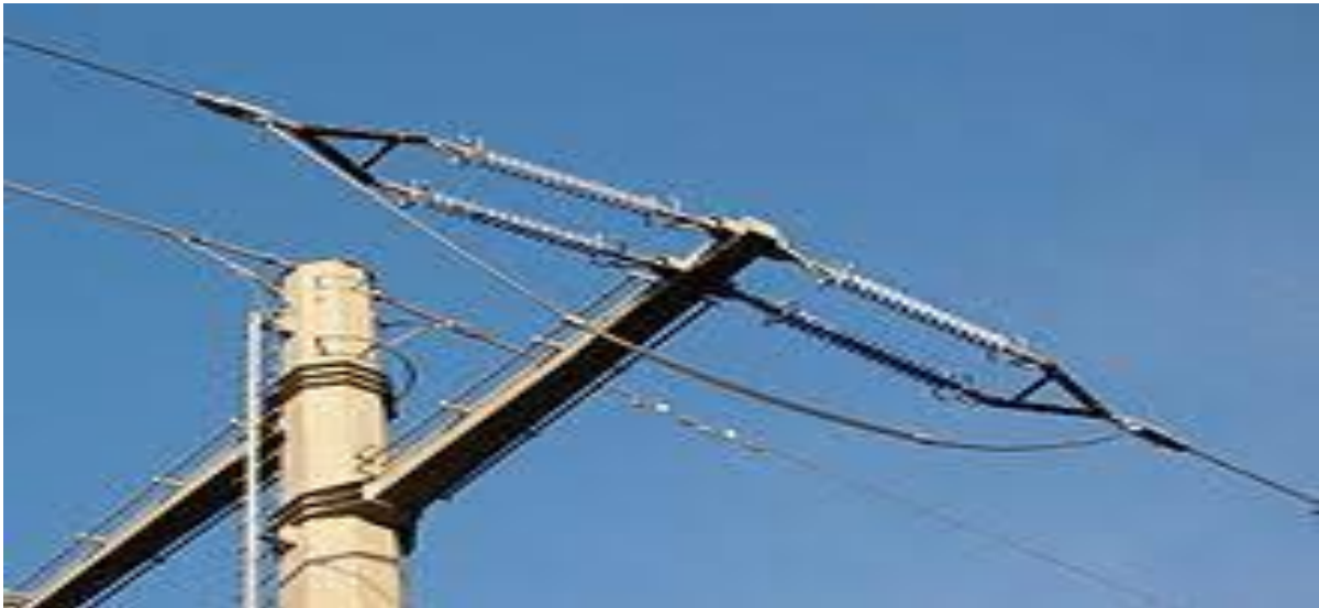
Figure II.7 : disposition horizontale des chaînes d'isolateur
