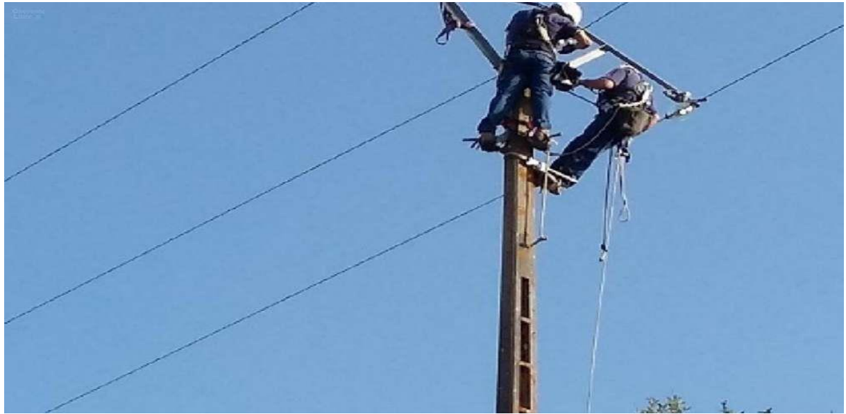
Figure II.10 : travaux d'entretien sur la ligne de haute tension.
