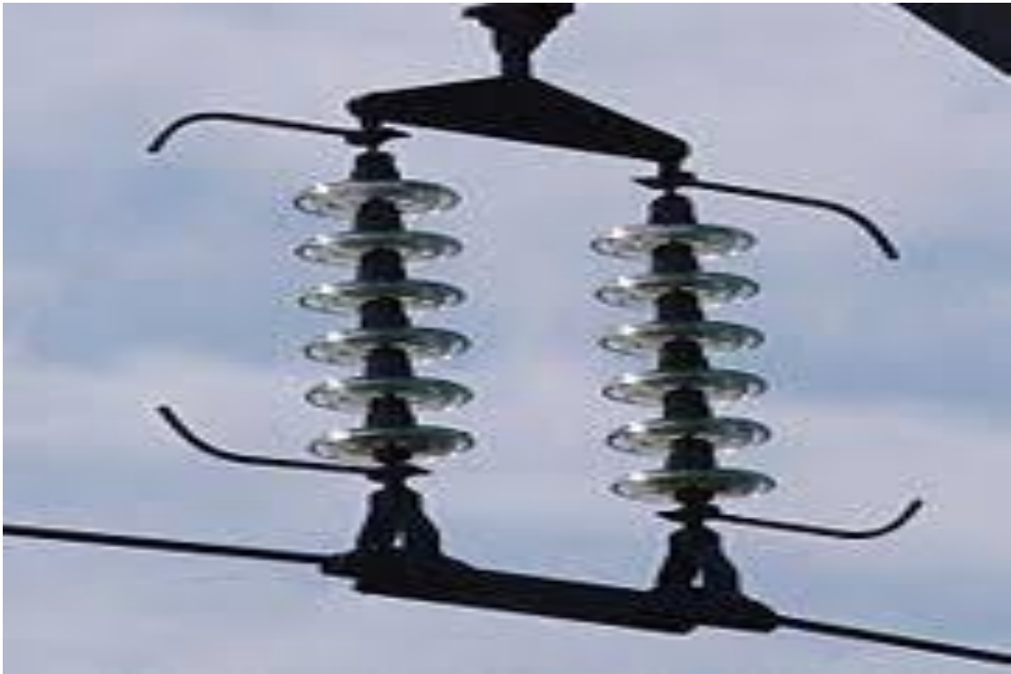
Figure II.5 : disposition verticale des chaînes d'isolateur
