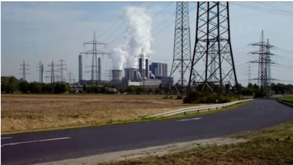
Figure II.4 : Lignes haute tension soumises à la pollution industrielle
