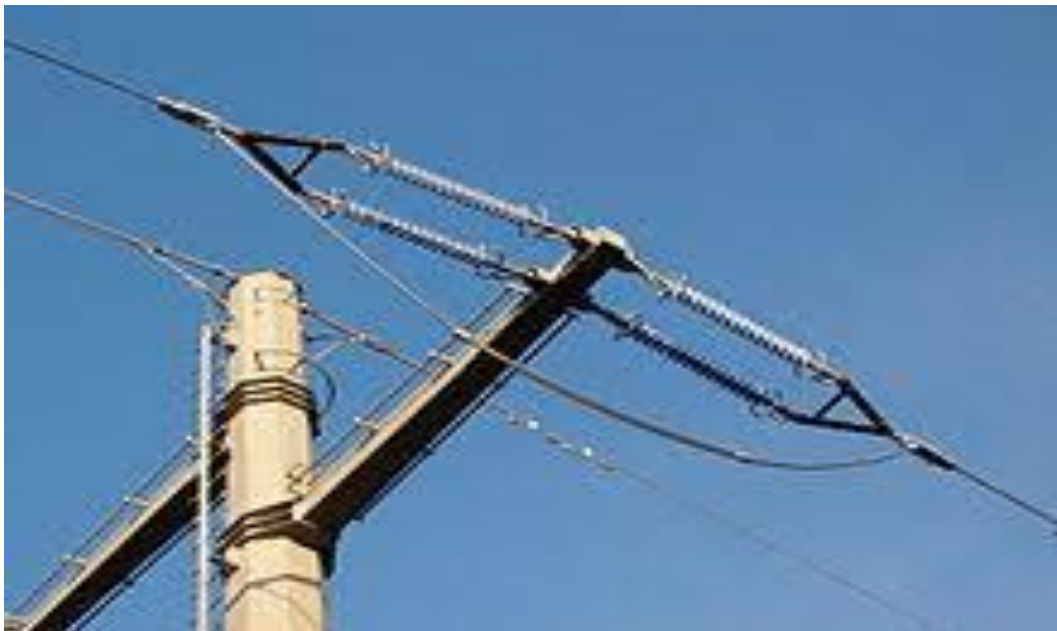
Figure I.3 : chaîne d'ancrage
