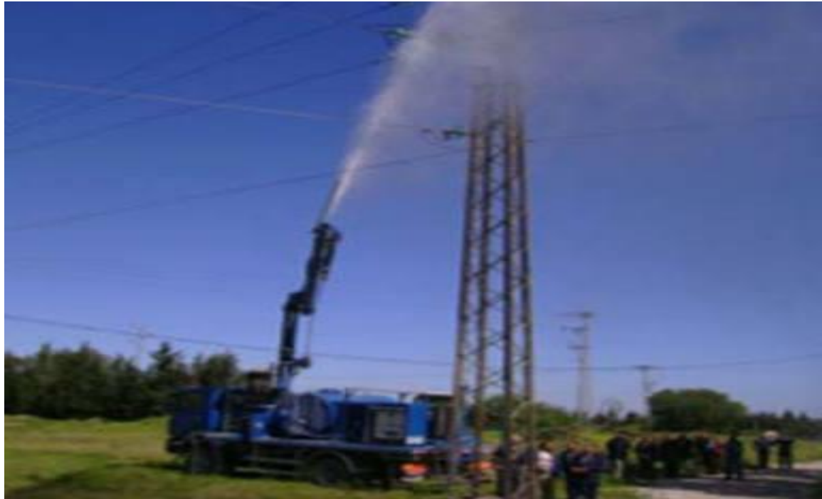
Figure II.9 : Nettoyage des isolateurs de ligne haute tension
