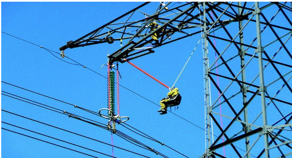
Figure II.8 : entretien des chaînes d'isolateurs (lavage)
