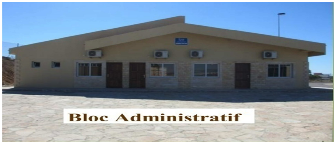
Figure N° 07 : Le bloc administratif.
