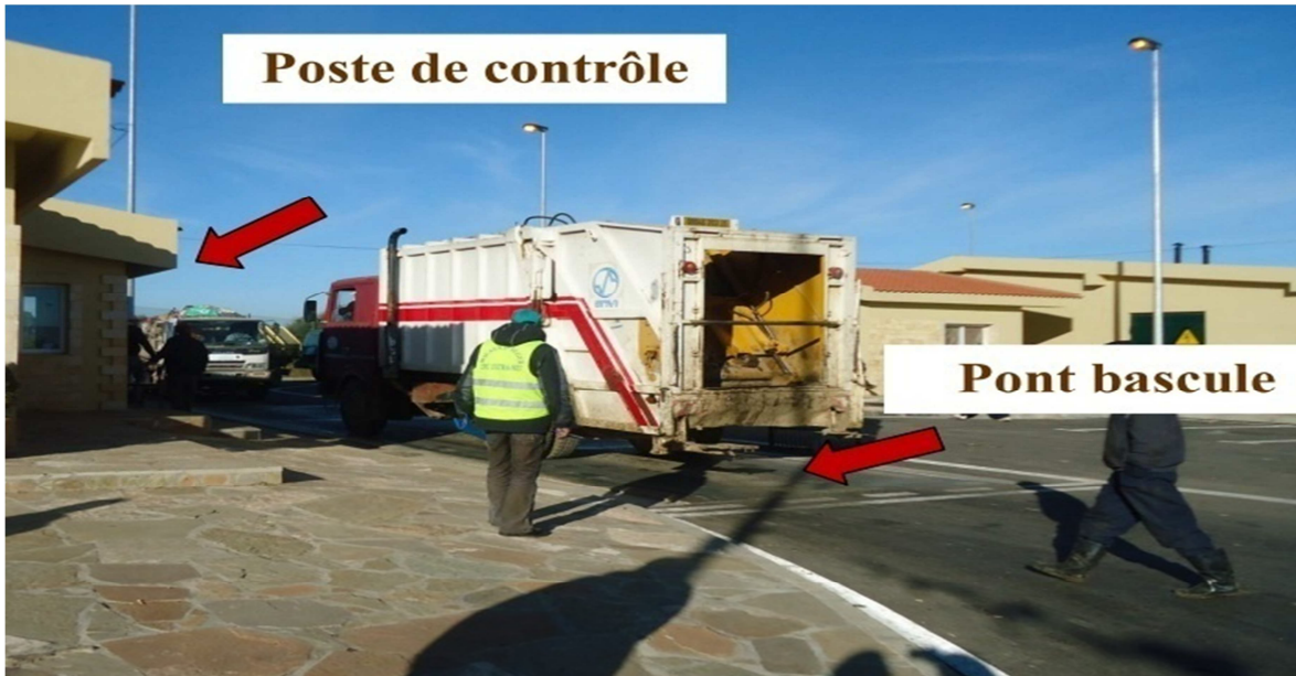
Figure N° 06 : poste de contrôle et pont-basculer
