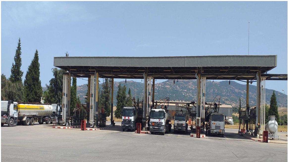
Figure I-8 : poste de chargement des camions
