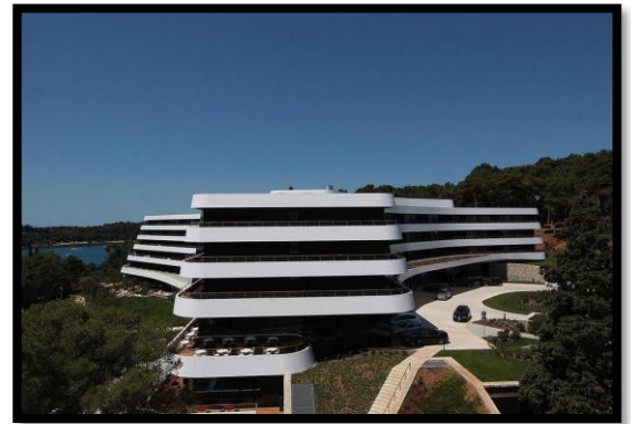
Figure 151 : façade de l'hôtel Source : http://www.archiscene.net
