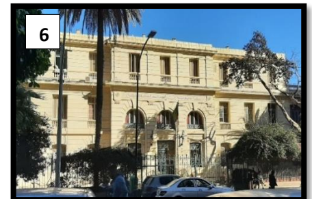
Figure 107 : Lycée technique. Source : Auteurs.
