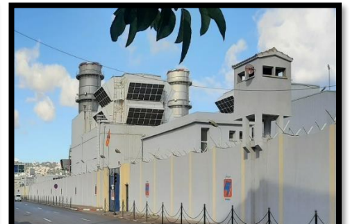
Figure 64 : Centrale électrique d'El Hamma. Source : Auteurs.
