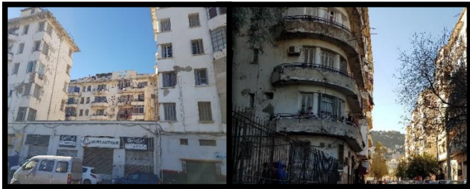
Figure 50 : Bâti moyen état. Source : Auteurs.
