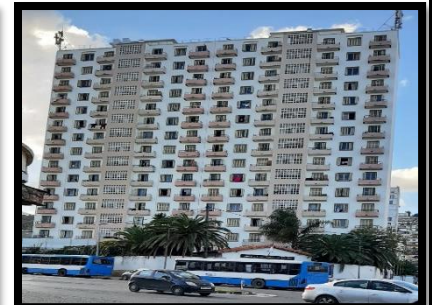
Figure 58 : Bâti à grande hauteur.
