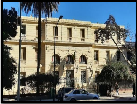
Figure 59 : Lycée technique. Source : Auteurs.
