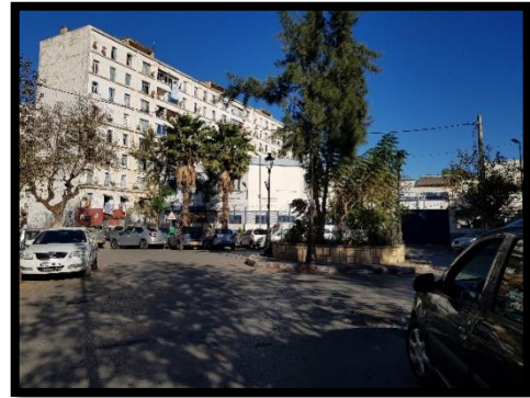
Figure 88 : Rue Boualem Bouchaib. Source : Auteurs.
