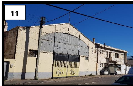
Figure 112 : Usine Hammoud Boualem. Source : Auteurs.
