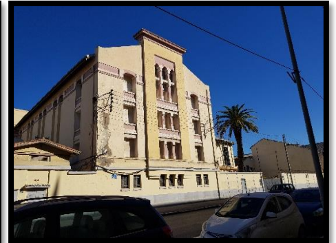
Figure 61 : Usine Hamoud Boualem. Source : Auteurs.
