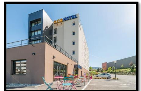
Figure 140 : ACE Hôtel Annecy Source : google photos
