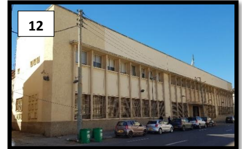
Figure 113 : Usine Hammoud Boualem. Source : Auteurs.
