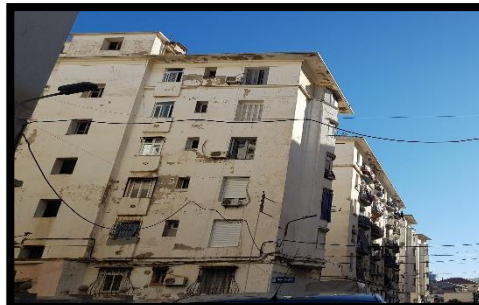
Figure 57 : Bâti à moyenne hauteur.
