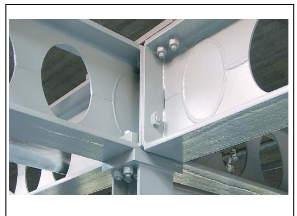
Figure 241 : Poutre alvéolaires
