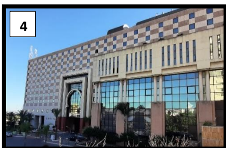
Figure 105 : Hôtel Sofitel. Source : Auteurs.
