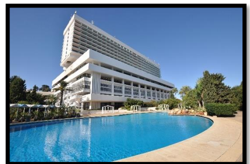
Figure 143 : Hôtel EL-AURASSI alger Source : google photos
