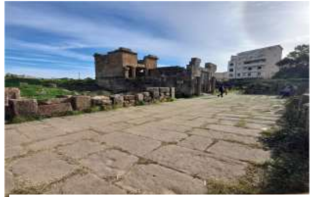
Photo 20 : parcours issus de l'ancien tracé Source : auteurs
