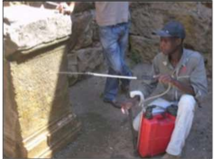
Photo 10 : image de travaux de nettoyage avec un jet d'eau
