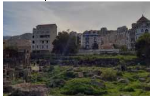
Vue sur le bâti du côté Sud Source : auteurs
