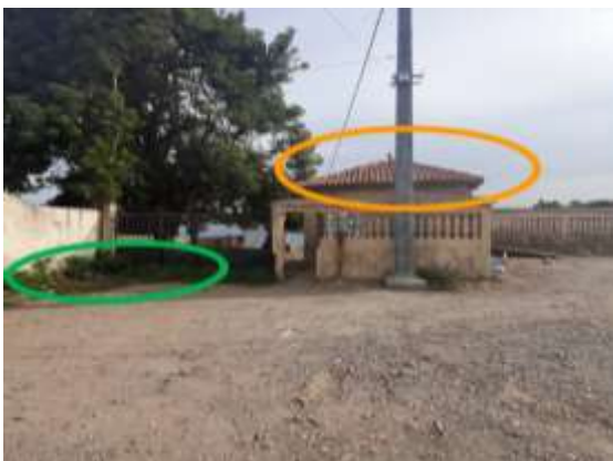
Figure 27 : entrée secondaire Source : traitée par auteures
