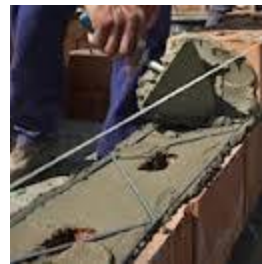
Fig .4.3. Forme d'armature murfor
