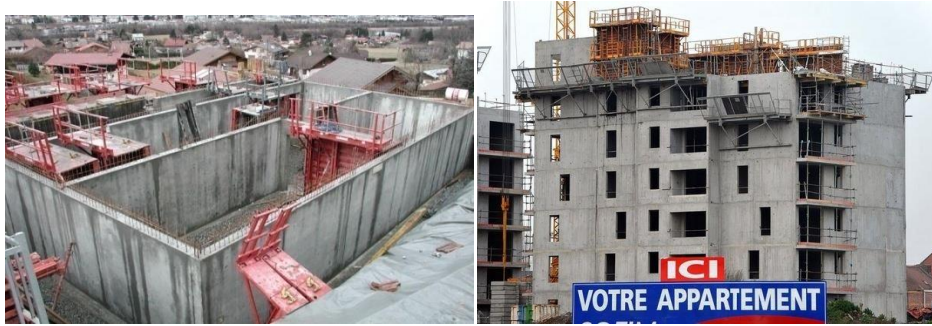
Fig. 1.2. Bâtiments contreventés entièrement avec voiles porteurs
