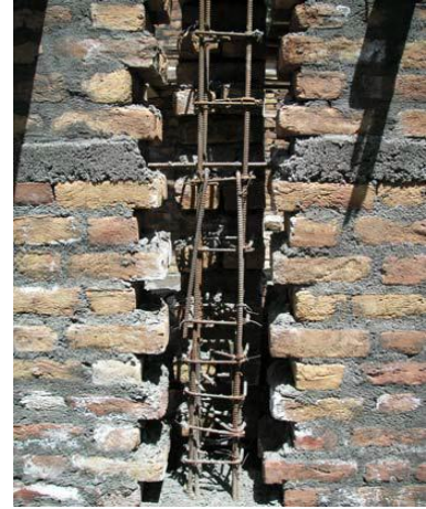
Fig. 1.14. Système de harpage utilisé par la maçonnerie chaînée
