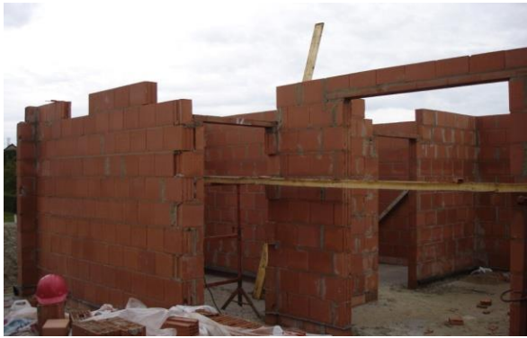
Fig. 1.14. Système de harpage utilisé par la maçonnerie chaînée
