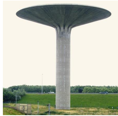
Fig. 1.6. Système fonctionnant en console verticale
