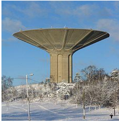
Fig. 1.6. Système fonctionnant en console verticale
