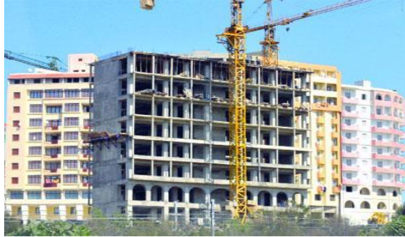
Fig. 1.4. Bâtiment contreventé avec portique et voiles
