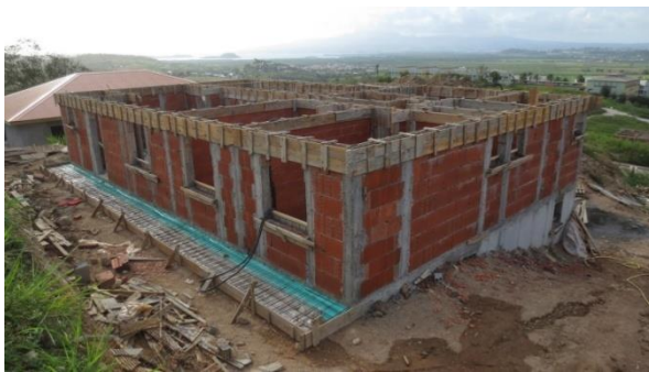
Fig. 1.15. Exemple de construction de maçonnerie chaînée
