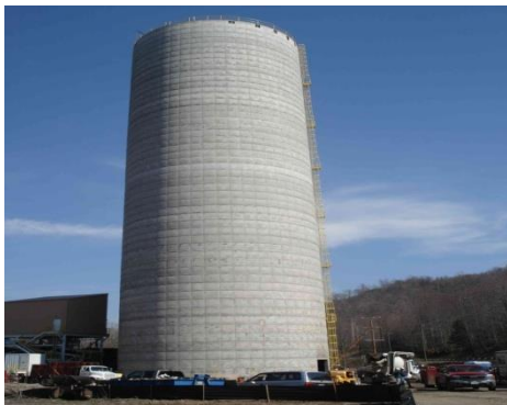
Fig. 1.7. Réservoirs d'eau sur jupe cylindrique
