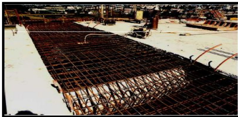
Fig. II.9 : Ferrailage du voussoir de Clavage.
