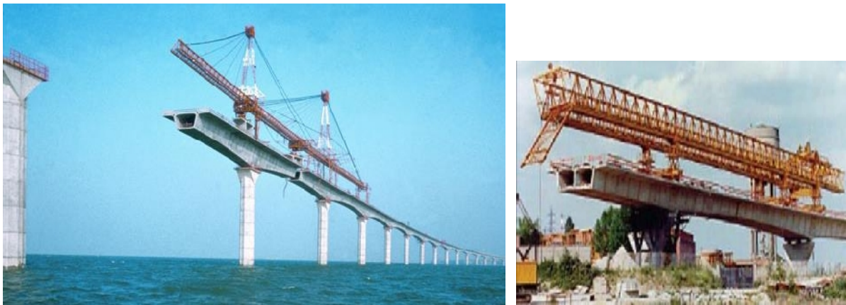
Fig. I.7 : Construction du viaduc de l'Ile de Ré à l'aide d'une poutre de lancement.
