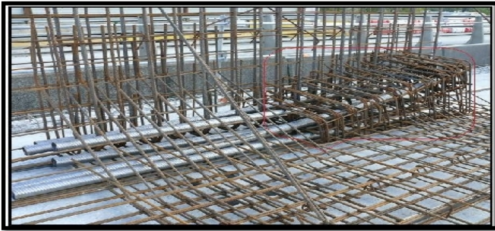
Fig. IX. 3. Ferrailage du bossage dans un voussoir [Réf.15].
