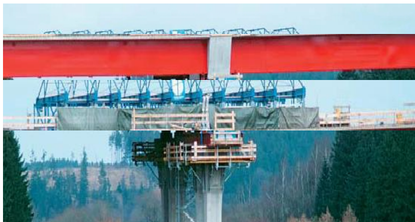
Fig. I.10 : Tablier coulé sur cintre.
