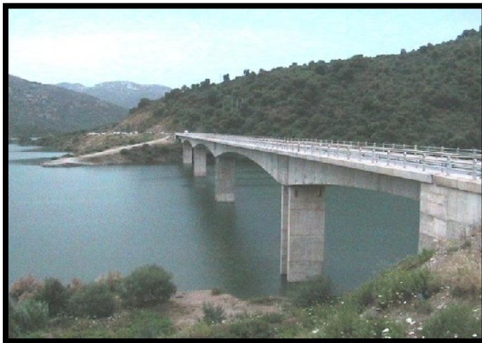
Fig. I.2 : Pont à poutre caisson (Taksebt, Tizi Ouzou).
