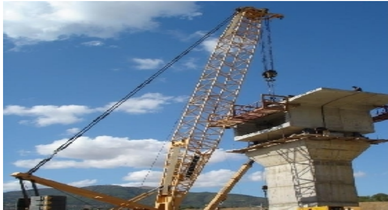
Fig. I.8 : La pose des voussoirs par grue.
