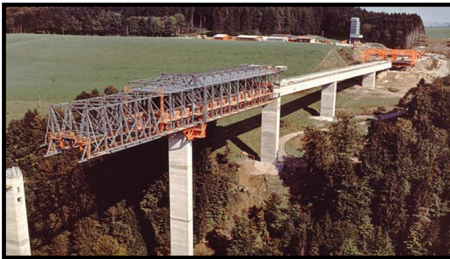
Fig. I.11 : Construction par poussage.
