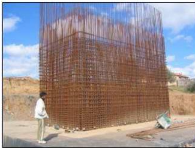
Fig. XI.3. Ferrailage de la pile en élévation.
