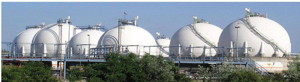
Figure. I.2 : Réservoirs de gaz à Karlsruhe (Allemagne).
