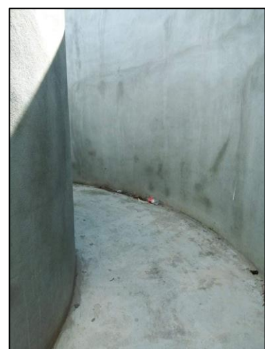
Figure 100: Rampe de service Source : Auteurs
