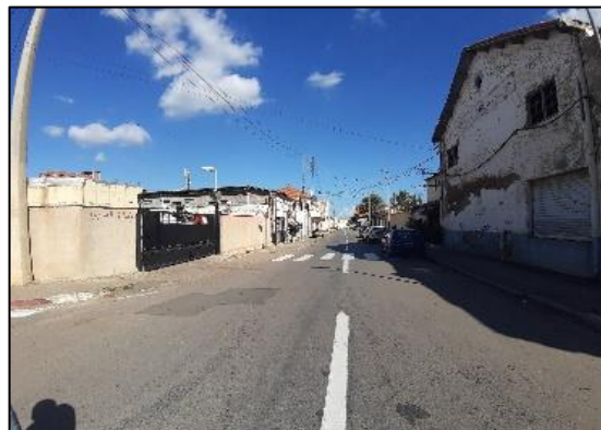
Figure 48 : Hangars et habitation ( R / R+1) Source : auteurs
