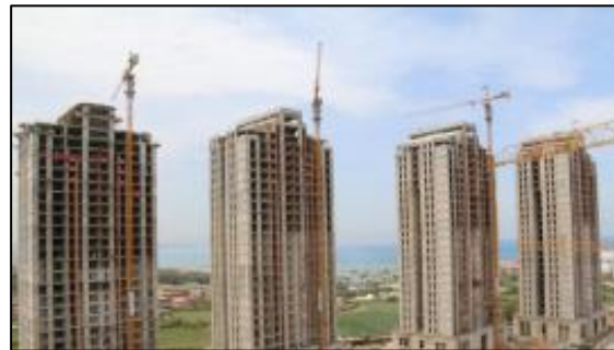
Figure 75 : forum el Djazair en cours de construction
