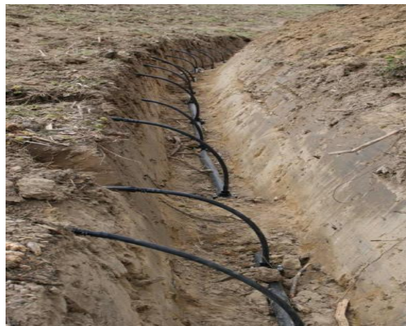
Figure I. 13: irrigation par goutte à goutte (Système souterrains)
