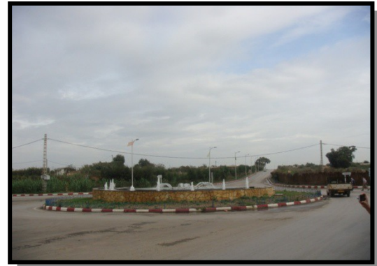
Le carrefour de l'intersection de la RN63 avec l'axe périphérique de contournement
