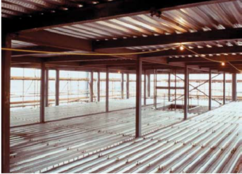
FIG I.1 structure mixte avant bétonnage du plancher. [6]
