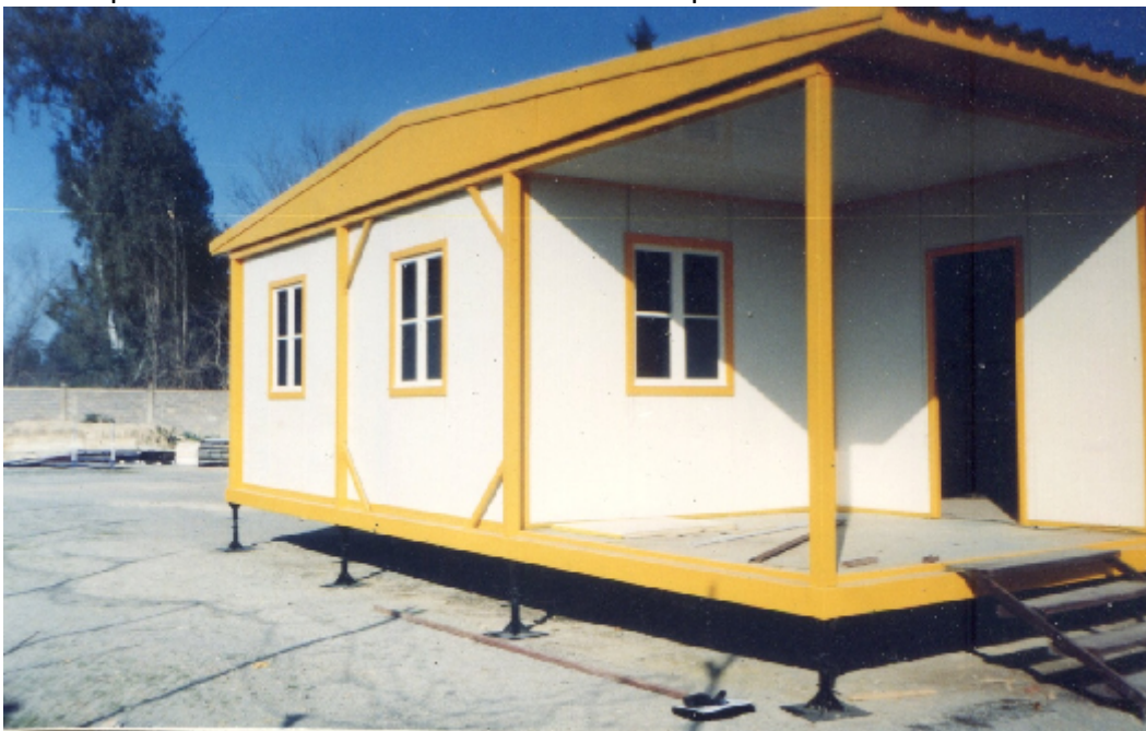
FIG I.5 chalet mobiles à montage et démontage rapide montés sur vérins mécaniques.
