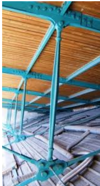
FIG I.23 élément de construction forgé
