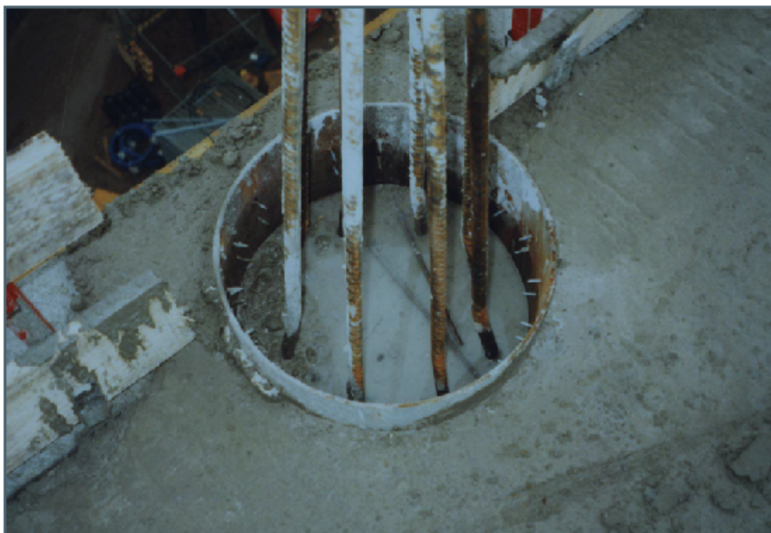
FIG I.12 poteau mixtes béton armé confinés et connecteurs [6]
