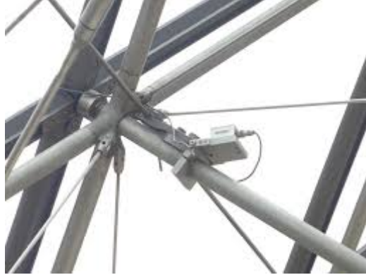
FIG I.22 élément de construction moulé [20]
