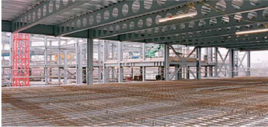
FIG I.3 structures mixtes avec poutres alvéolaires. [6]
