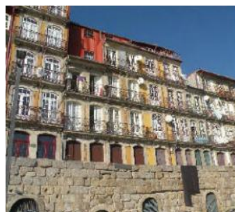
Figure 74 Logements réhabilités. Source : support web
