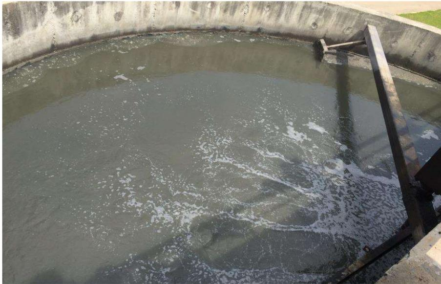
**Figure n°II.1 : Graisses flottantes en surface**
