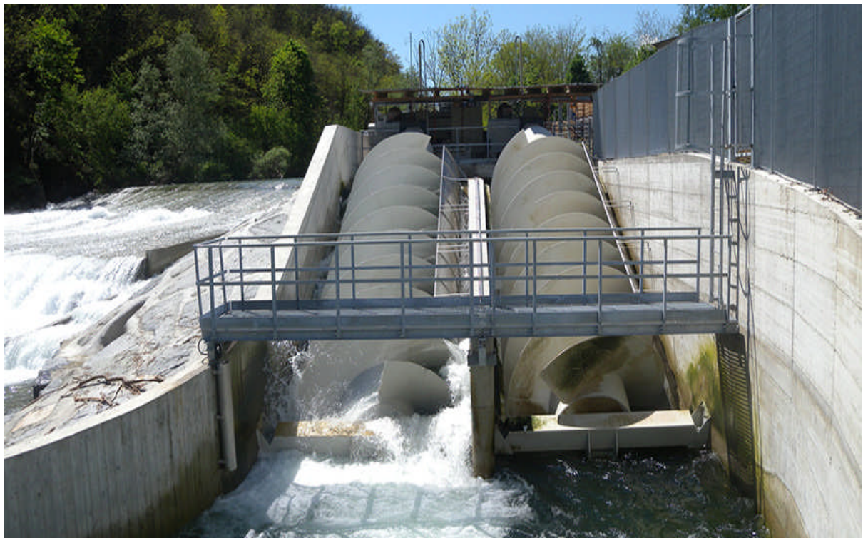
Figure 2.7 : Photo de turbine à vis d'Archimède
