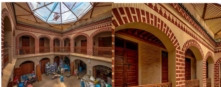
Figure 16: Fondouk Touma après sa réhabilitation.
