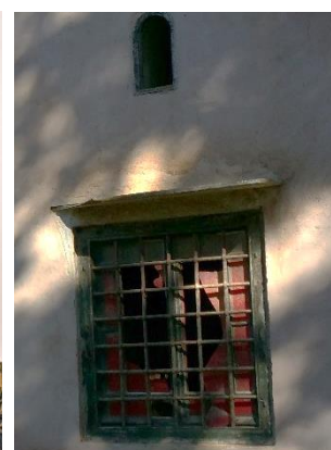
Figure 19 : fenêtre extérieur de Djnen Lakhdar source : auteur
