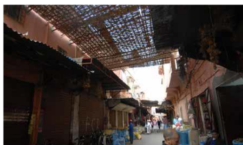
Figure 7 : l'allée avant l'aménagement
