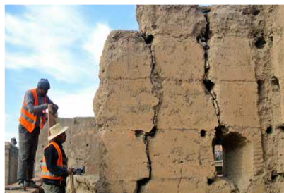
Figure 14 : muraille avant l'intervention
