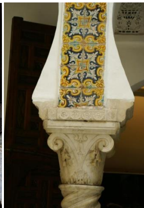
Figure 17 : colonne d'une maison casbah source : www.Wikipédia.com
