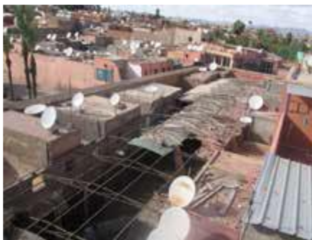
Figure 24 : les couvertures de souk les plus diverses : roseaux, bâches, plastiques et tôles ondulées.
