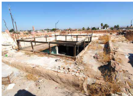
Figure 20: les terrasses avant la réhabilitation
