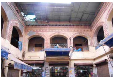
Figure 17: Fondouk Touma avant sa réhabilitation.
