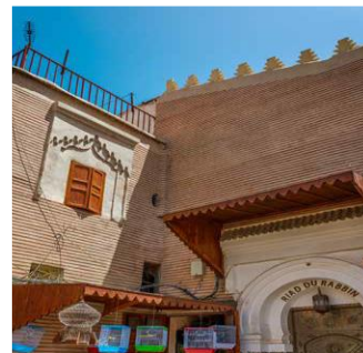
Figure 18: Les façades des riads réhabilités
