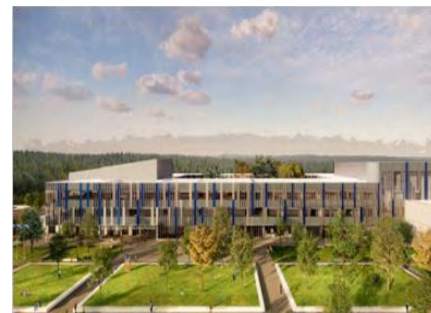
Figure 87:ouverture de l'école LPP
