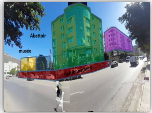
Figure 44:photo de paroi gauche
