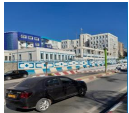
Figure 34:photo de paroi gauche
