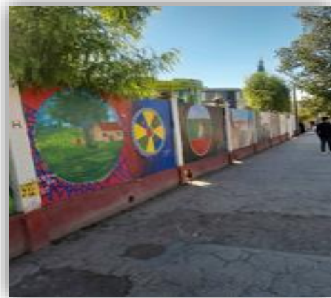
Figure 42: photo de paroi droite du 2eme tronçon
