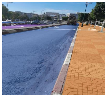
Figure 37: photo de deuxième tronçon
