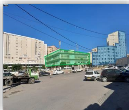
Figure 39: photo de paroi gauche
