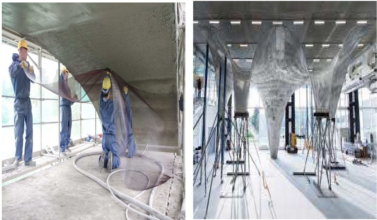
Figure I-11 : Application intérieur d'un TRC
