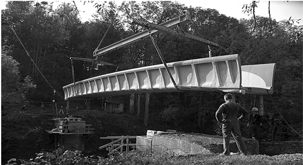
Figure-I-10 : Installation de la passerelle pour piétons en TRC (portée 16 m) à Kempten (Allemagne)
