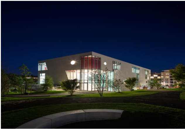
Annexe 11 : Vue sur la façade textile, source : image Google maps.
