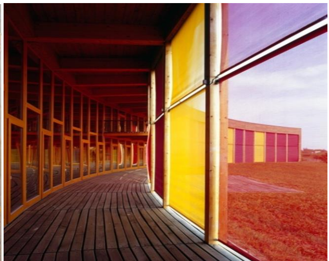
Annexe 16 : Vue sur les stores mobiles, source : archdaily.
