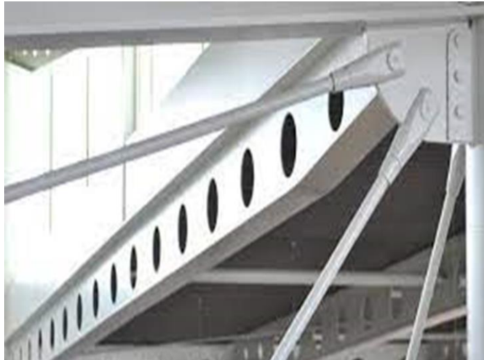
Figure79 : poutre métallique alvéolaire, source :
