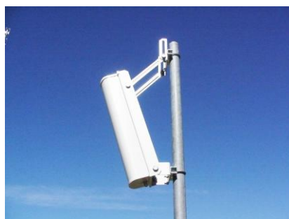
Fig.48 : Antenne sectorielle.
