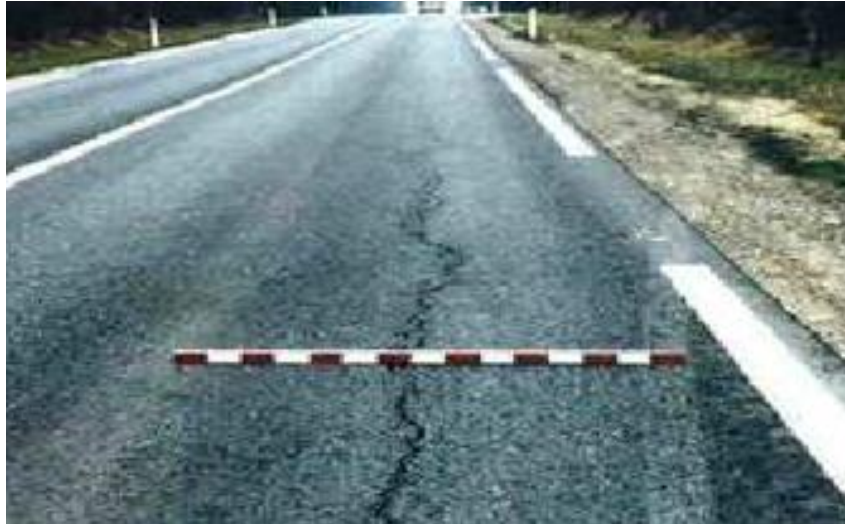
Figure 10.I. Fissuration longitudinale.
