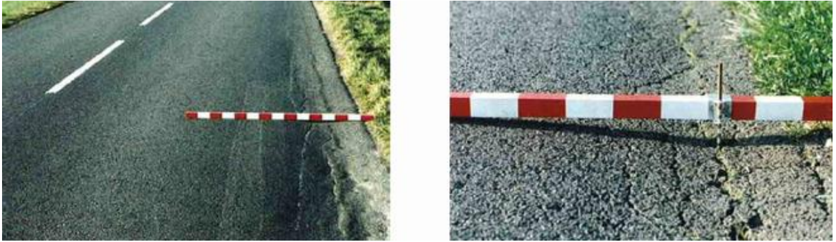
Figure 8.I. Affaissement hors rive.
