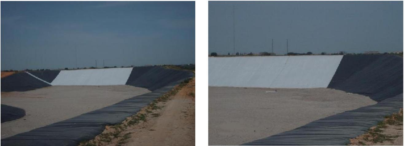
**Figure 04 :** la pose du géotextile
