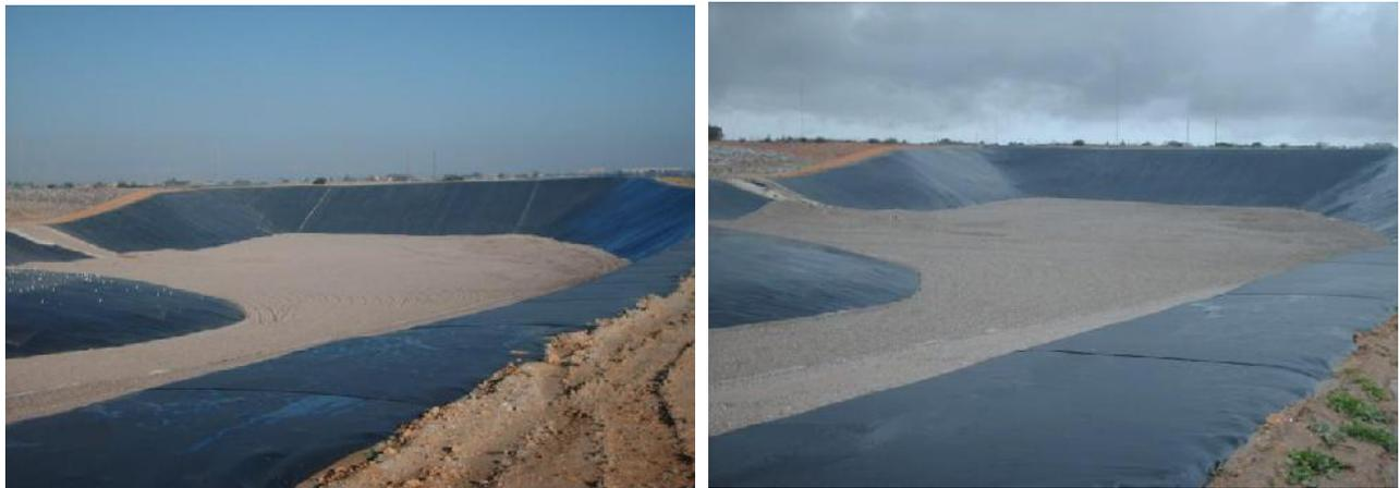
**Figure 03 :** La pose de la géomembrane en polyéthylène à haute densité (PEHD).
