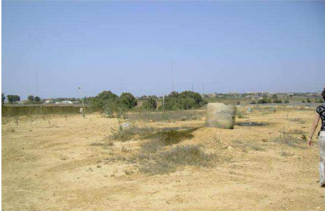
Figure 06 : Buse d'évacuation du biogaz, Ouled Fayet.
