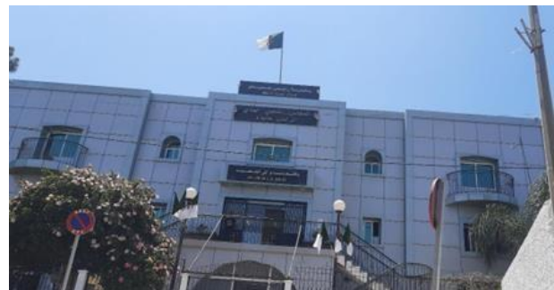
Photo 24 : siège de l'APC (source: POS N°83)
