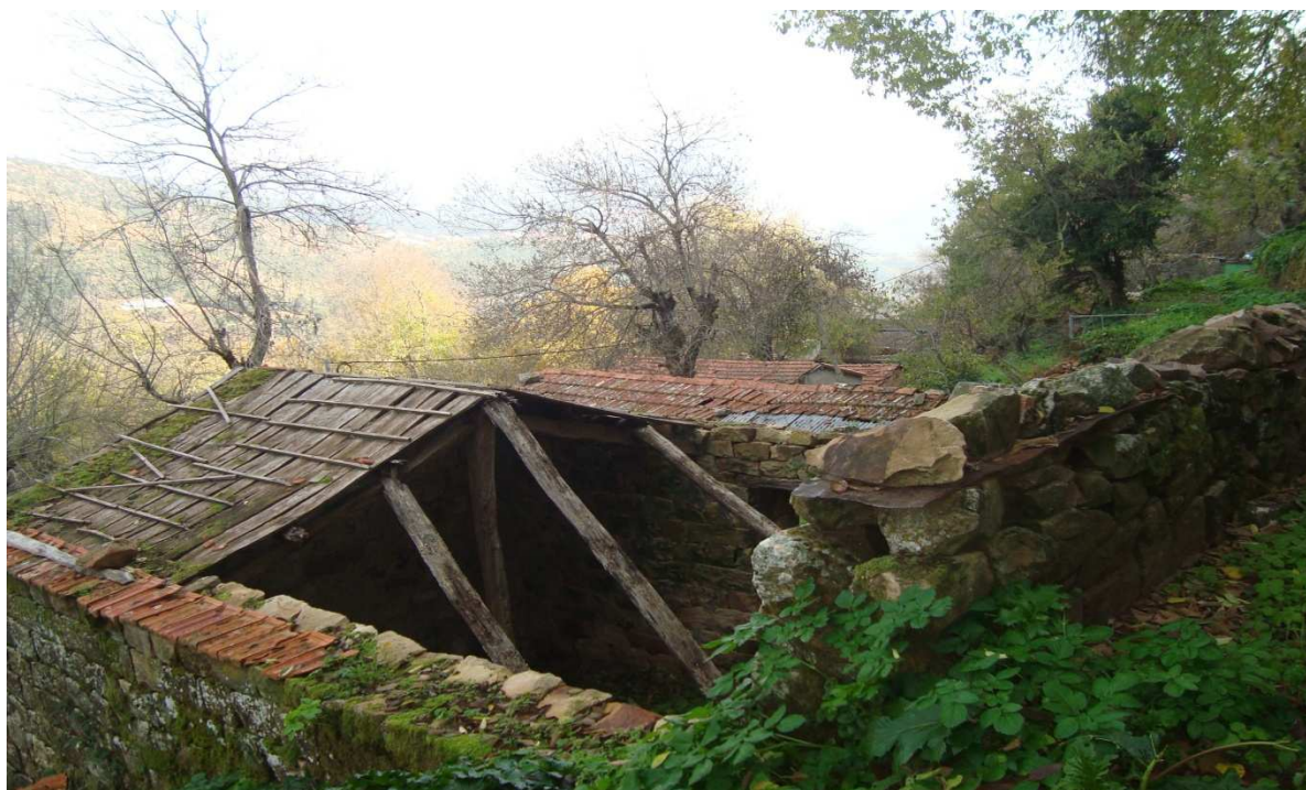
Photos 28: Eléments composants la toiture dans les Maisons traditionnelles kabyles à MOKNEA (Source : Photographie de l'Auteur)
