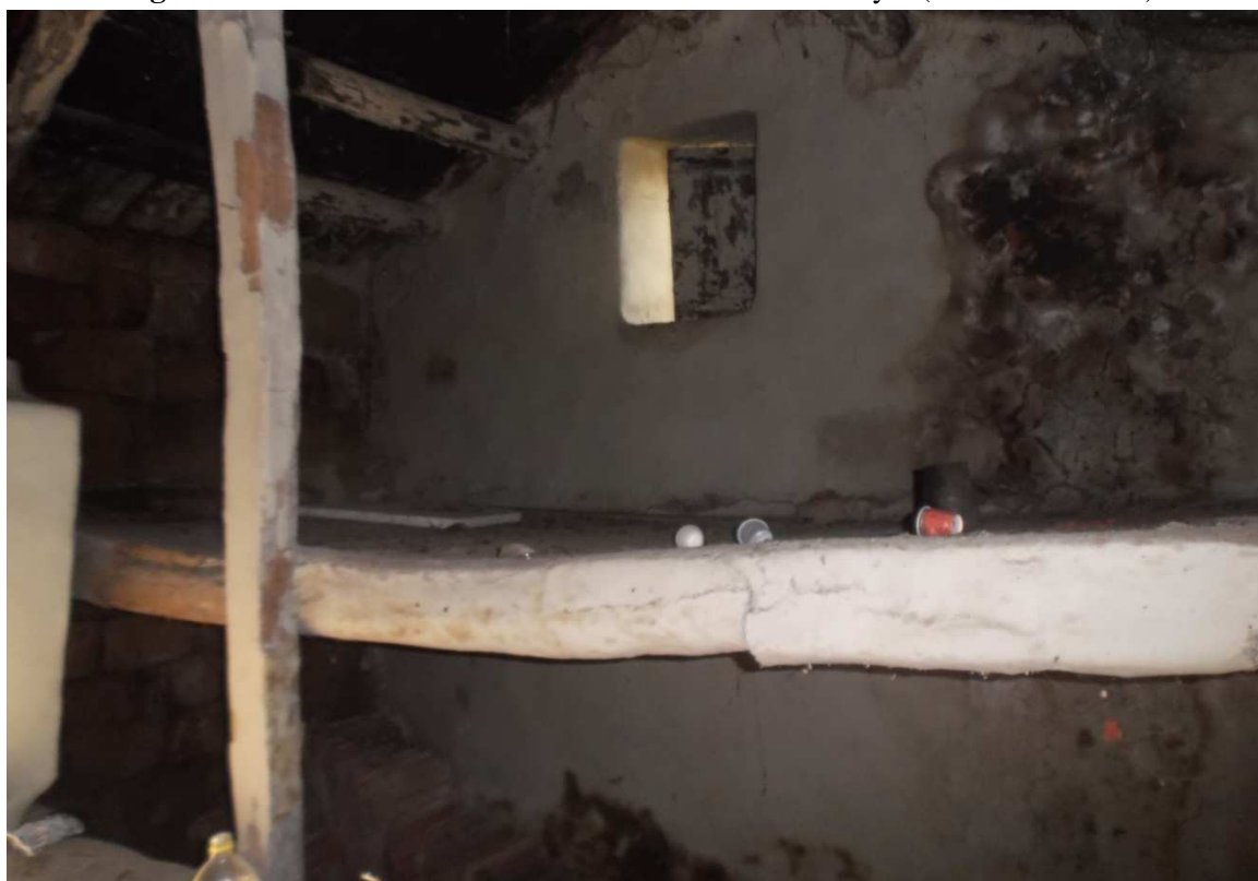
Photos 26: Les planchers (Thaaricht) dans les Maisons traditionnelles kabyles à MOKNEA (Source : Photographie de l'Auteur)
