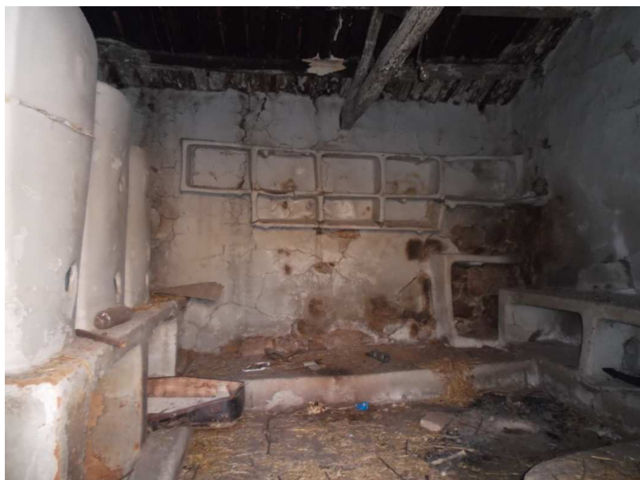
Photos 29: Les revêtements dans les Maisons traditionnelles kabyles à MOKNEA (source : Photographie de l'Auteur)
