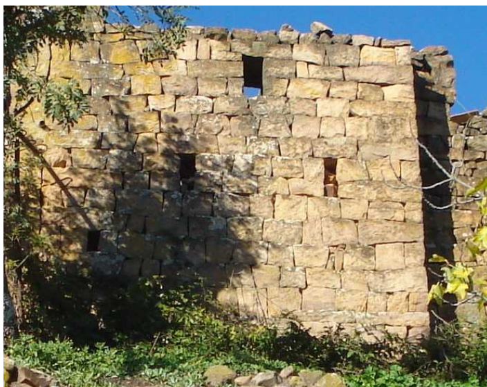
Photos 12 : Utilisation de la pierre dans une Maison traditionnelle kabyle à MOKNÉA (source : Photographie de l'Auteur)
