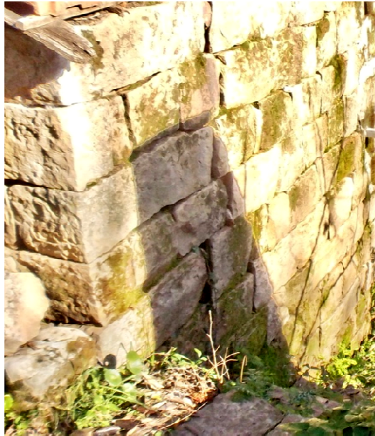
Photos 19: Photo et croquis d'un Mur porteur d'une Maison traditionnelle kabyle à MOKNÉA (source : Auteur)
