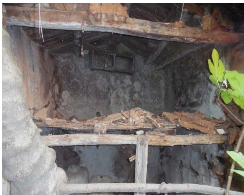
Photos 25: Les planchers dans les Maisons traditionnelles kabyles à MOKNEA (source : Photographie de l'Auteur)
