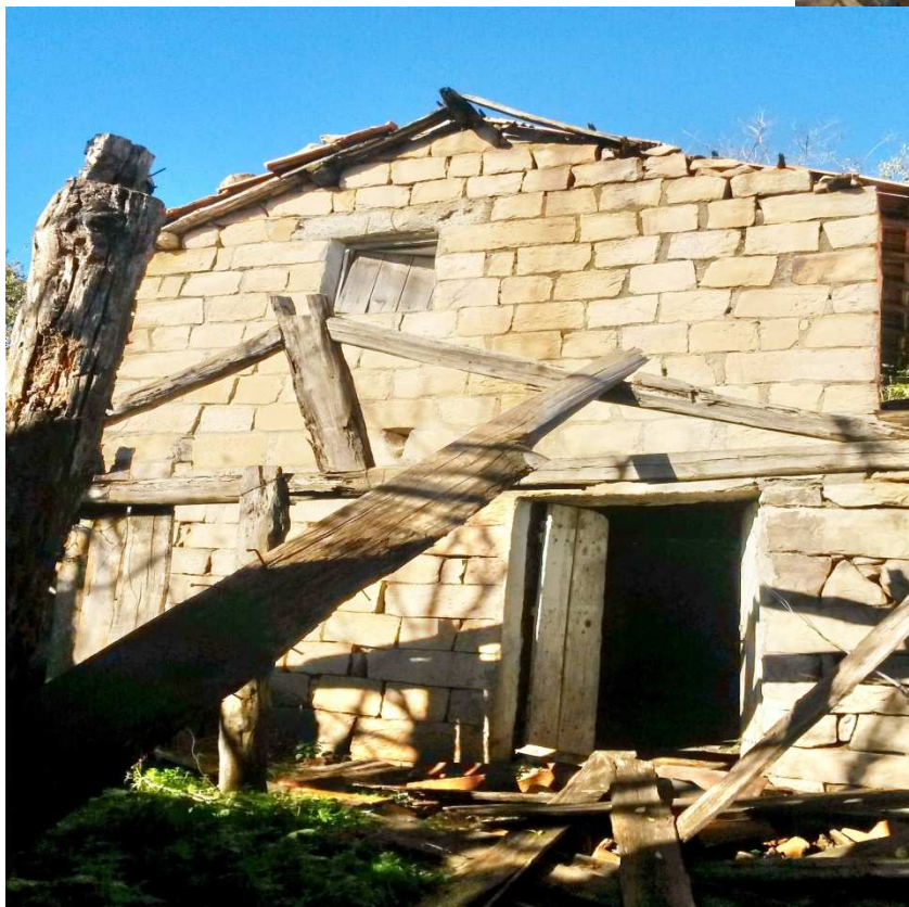
Photos 13 : Utilisation Bois dans une Maison traditionnelle kabyle à MOKNÉA (source : Photographie de l' Auteur)
