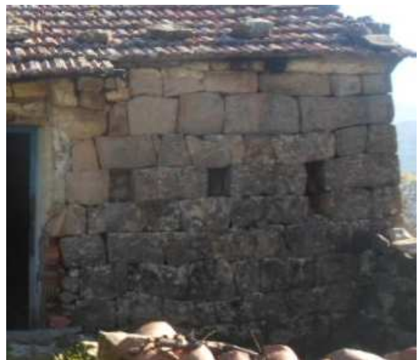
Photos 16: Appareillage des Maisons traditionnelles kabyles à MOKNÉA (source : Photographie de l'Auteur)
