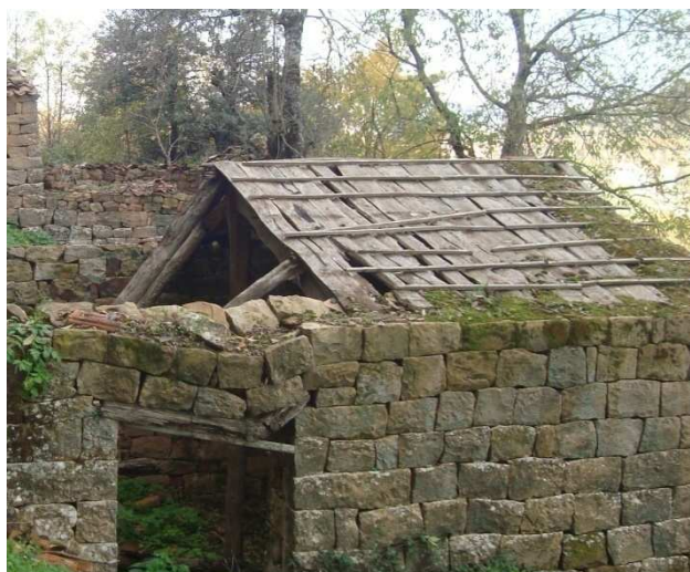
Photos 27: Les couvertures dans les Maisons traditionnelles kabyles à MOKNEA
