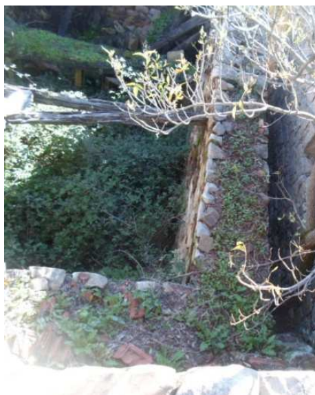
Photos 18: Murs porteur des Maisons traditionnelles kabyles à MOKNÉA (source : Photographie de l'Auteur)
