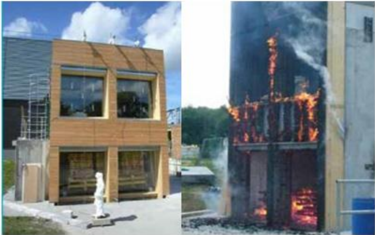
Figure II.12 : Maquette avant et après 30 mn du déclenchement de feu
