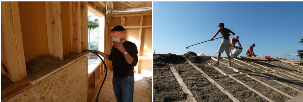
Figure III.28 : l'isolation extérieure des murs et toiture avec du la paille de lavande[21]
