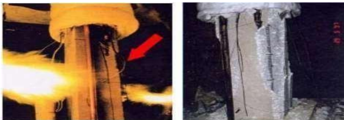
Figure II-2 : Eclatement d'un poteau durant l'essai au feu [12].
