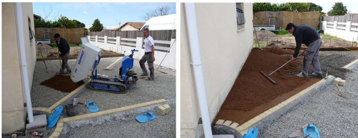
Figure I-15: Etalage du béton drainant [14].
