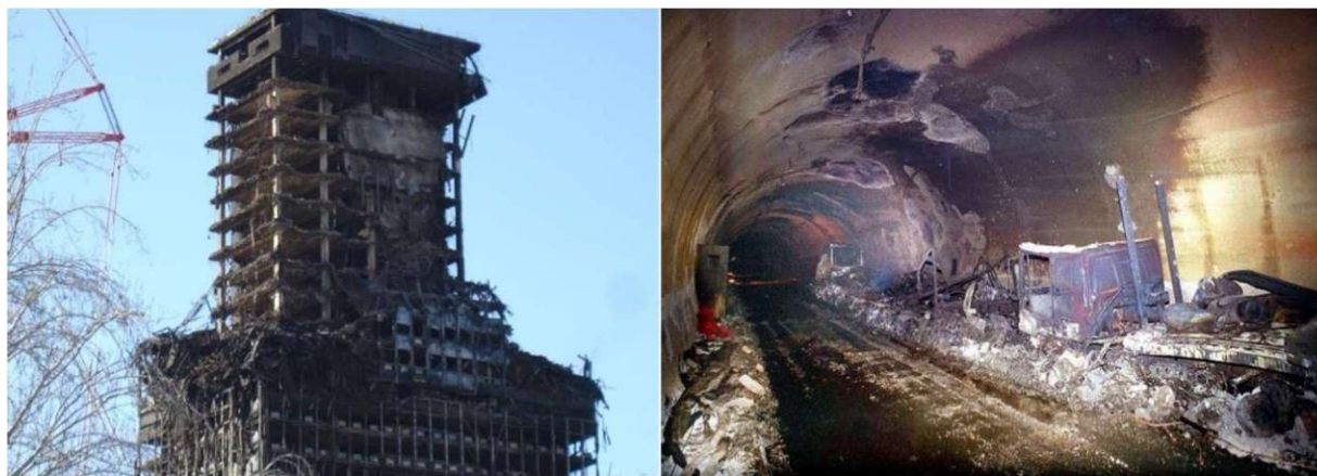
Incendie de Tour Windsor (Madrid) 2005
