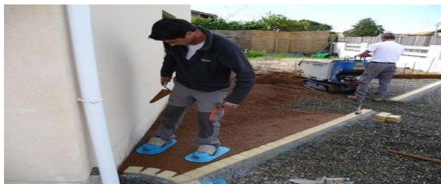
Figure I-16 : Damage du béton drainant [14].
