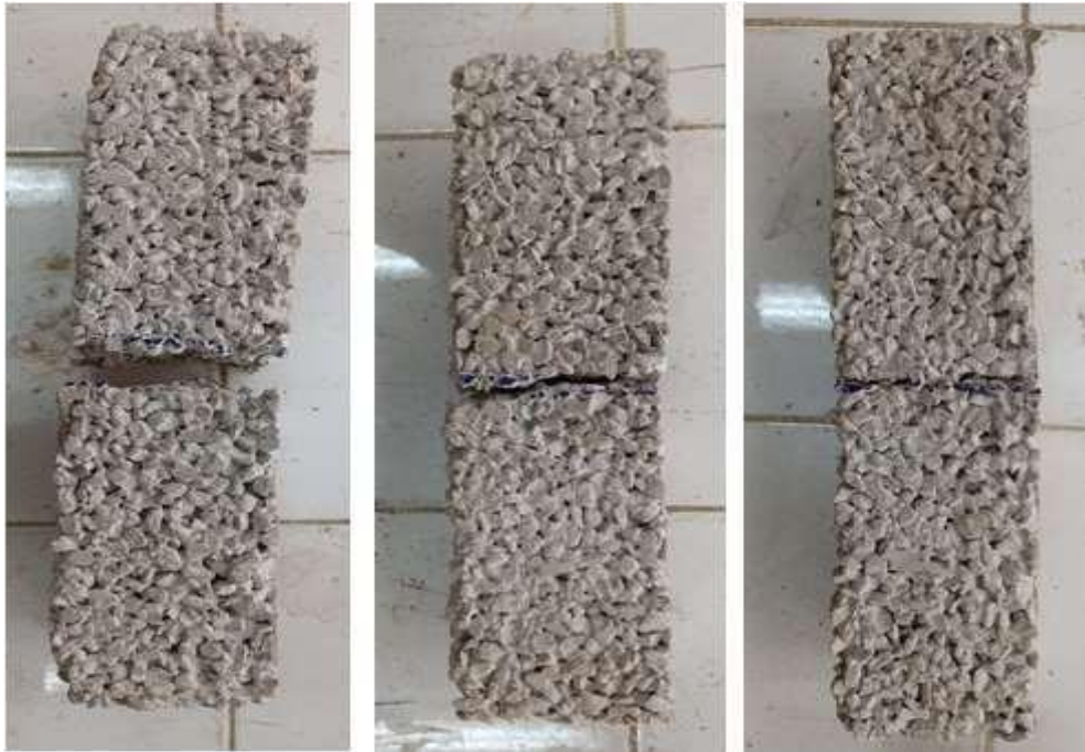
Figure IV-12 : Aspect des éprouvettes prismatiques après rupture.
