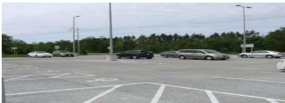
Figure I-11 : Parking en béton drainant [3].
