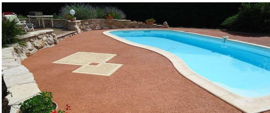
Figure I-12: Plage de piscine en béton drainant [13].
