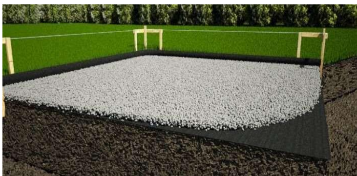
Figure I-13: Préparation du sol [14].
