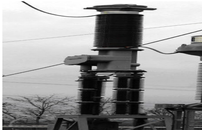
Fig .V.2 : Disjoncteur l'huile
