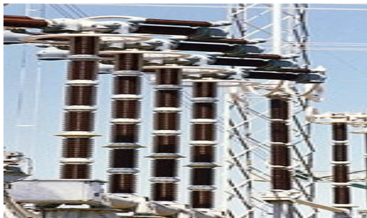
Fig.V.3 : Disjoncteur à air comprimé
