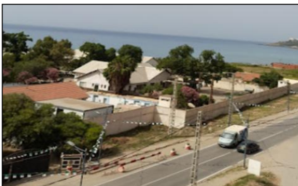
Photo 53 : Résidence NorSar Azeffoun Source : prise par l'auteur
