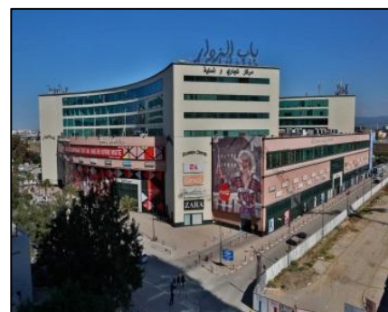
Photo 75 : centre commercial Bâb Ezzouar
