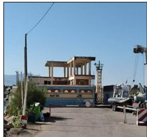
Photo 15 : station Naftal Source : prise par l'auteur
