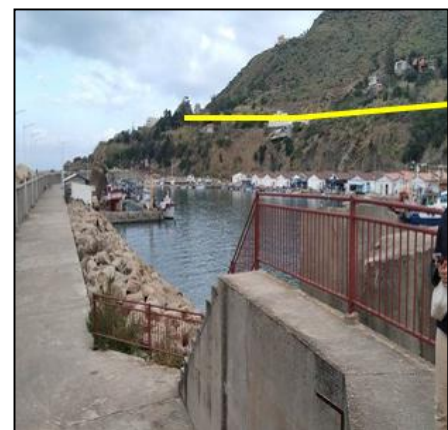
Figure 12 : la RN24 surplombe le port Source : prise par l'auteur
