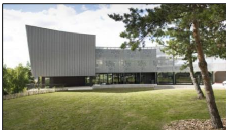
Photo 91: pole socio-culturel et Centre commercial - Le Puy en Velay Source : https://www.archiliste.fr/projets/atelier-architecture-urbanisme-mathais/pole-socio-culturel-centre-commercial-le-puy-en-velay
