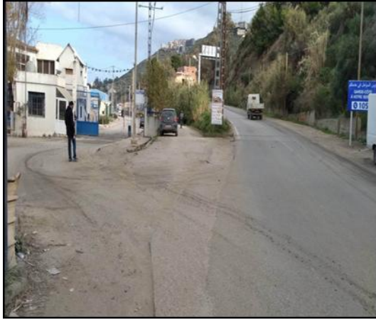
Photo 36 : nœud A Source : auteur
