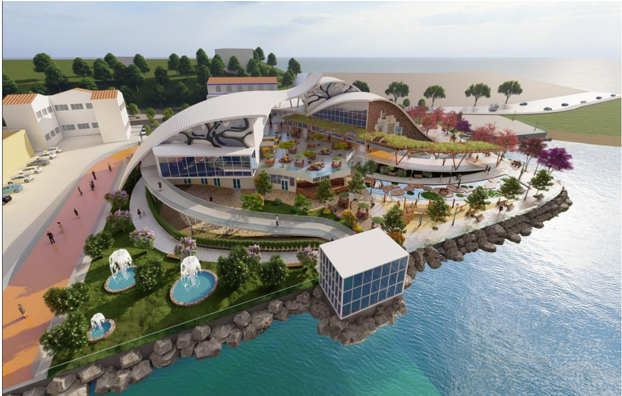
Façade postérieure “Nord”
