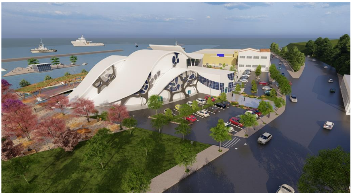
Vue latérale du côté Ouest
