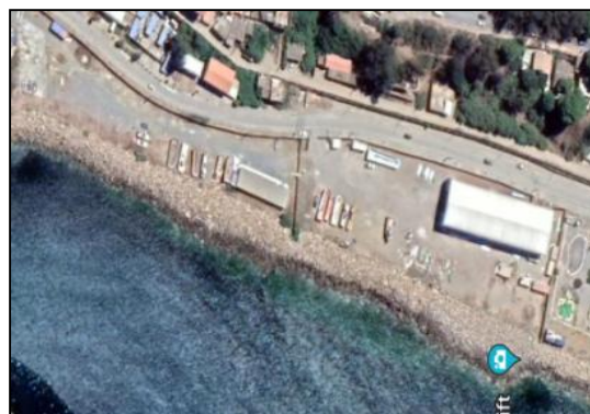
Figure 17 : vue aérienne sur la zone de production et de réparation des navires Source : prise par l'auteur
