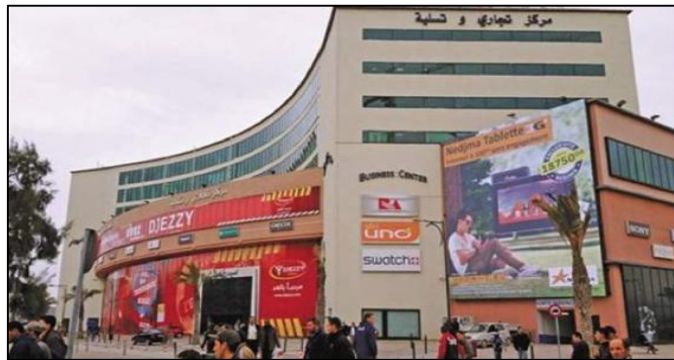
Photo 74 : Centre commercial Bâb Ezzouar
