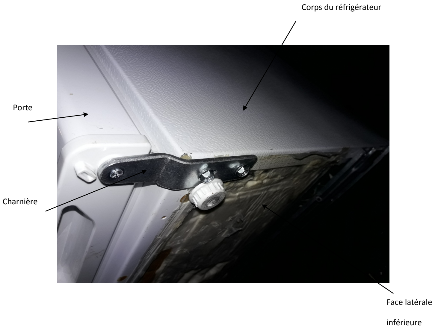
Figure 78 : Emplacement de la charnière sur le réfrigérateur
