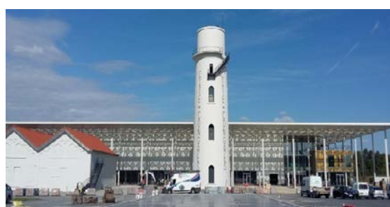
Figure 86. vue sur la façade principale du nouveau projet/ Source : www.chabanne-architecte.fr
