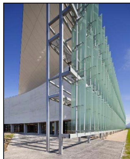
Les capteurs solaires, placés à l'extérieur, mesurent les rayons solaires Figure 185. Brises soleils orientable /Source : http://www.sadev.com/blog/brise-soleil-projet-ines/
