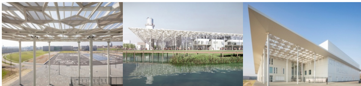
Figure 88. Vues sur es différentes façades / Source :
