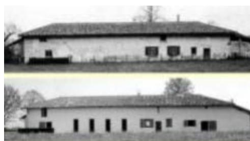
Figure 67. Réhabilitation d'un bâtiment/ Source : calvados.gouv.fr/IMG/pdf/dossier_rehabilitation.pdf
