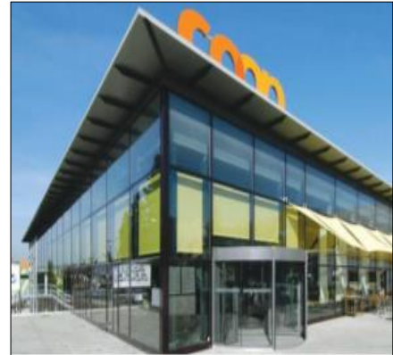
Figure :vue d'angle du centre commercial, source : https://architectes.ch/fr/architectes/bulle/atelier-d-architecture-a3-sa/centre-commercial-coop-le-caro
