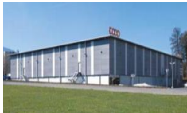
Figure : façade lisse, ventilée avec granit et tôle, source: https://architectes.ch/fr/architectes/bulle/atelier-darchitecture-a3-sa/centre-commercial-coop-le-caro
