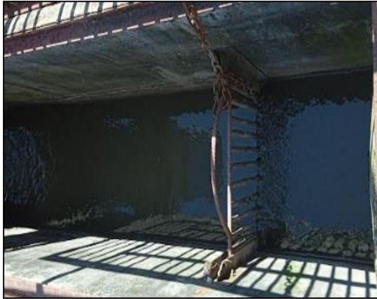
Figure 8 : Dégrilleur manuel.
