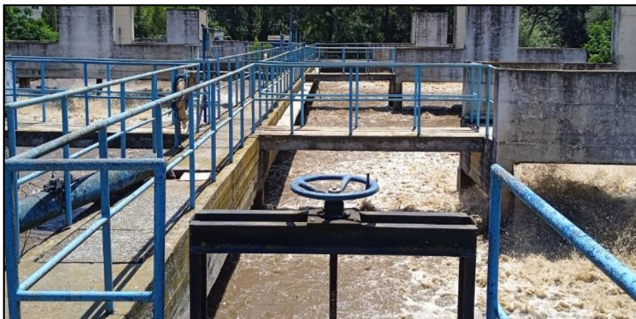
Figure 10 : Bassin d'aération.
