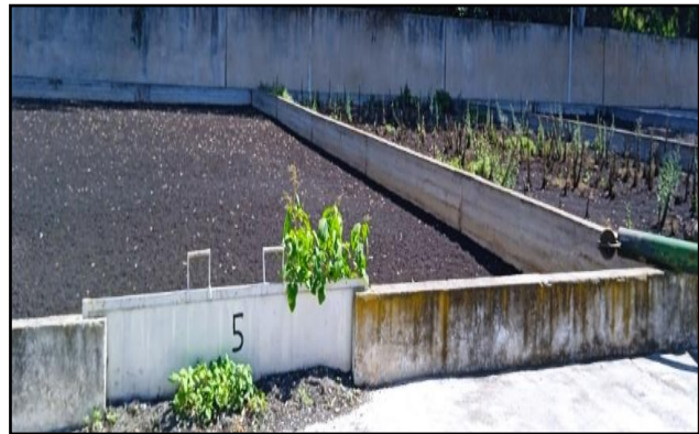
Figure 13 : Lits de séchage
