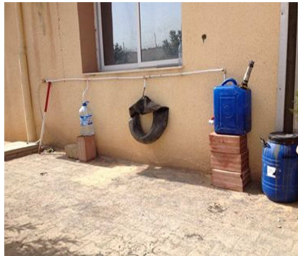
Photo 3. Montage du mini-digesteur destiné à abriter la digestion anaérobie des boues produites par le STEP de Djelfa
