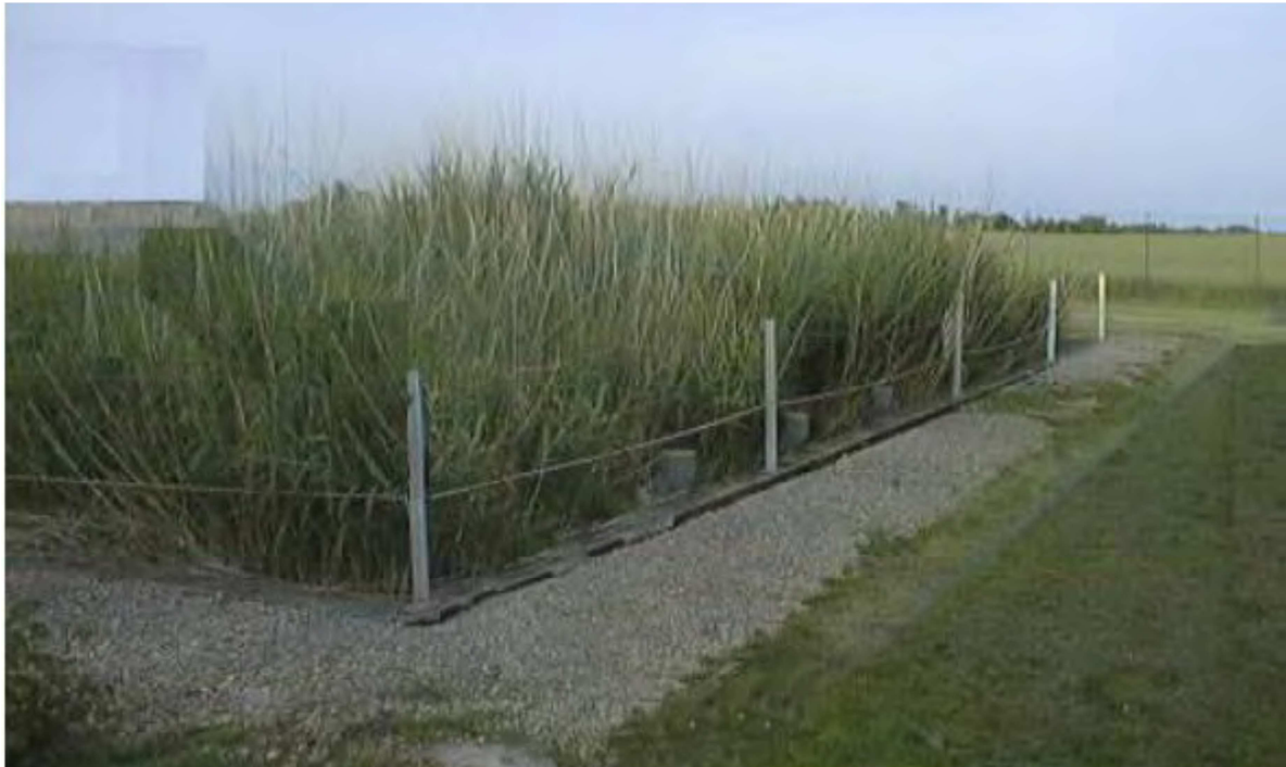
Photo 2. Lit de séchage planté de roseaux
